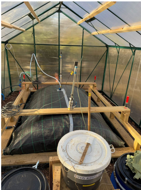
Abbildung 6: Stabilisierung des Gewächshauses mit einer Dachlattenkonstruktion
