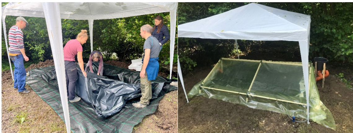
Abbildung 4: Erster Aufbau Mikro-Biogasanlage Am Ende des Workshops war der Fermentereintrag (rechts), sowie auch der Fermenteraustrag (links) fertiggestellt. Auch die Kondensatfalle und Überdrucksicherung des Biogassystems wurde angebracht (rechts unten).
