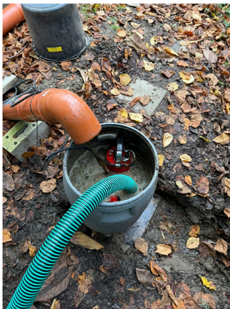
Abbildung 11: Rezirkulationspumpe am Substrataustrag
