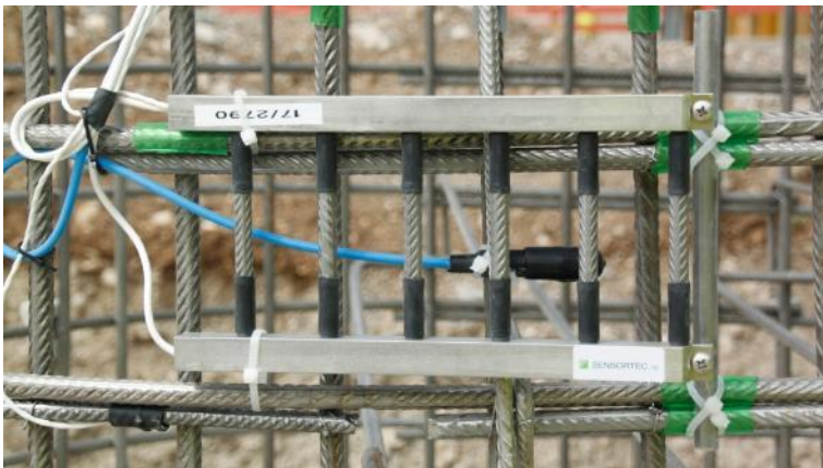
Abbildung 20: Korrosionssensor Anodenleiter nach Montage auf der oberen Bewehrungslage
