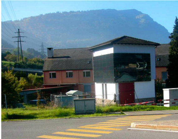
Figur 7 Fassadenintegration mit Dünnschichtmodulen (Bildquelle: Zagsolar)
