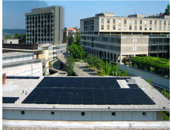
Figur 8 Teil der Flachdachanlage ETHZ (Bildquelle: Energiebüro)
