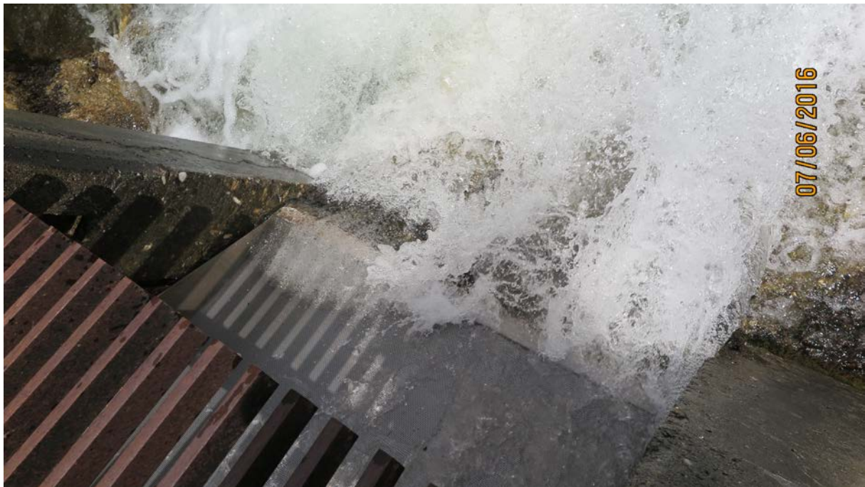
Abbildung 6: Detail Schutzrechen / Coandarechen
