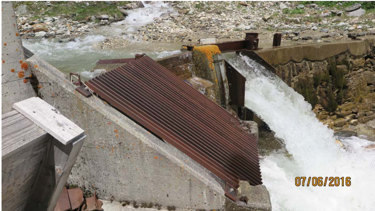
Abbildung 5: Geöffnete Spülschütze
