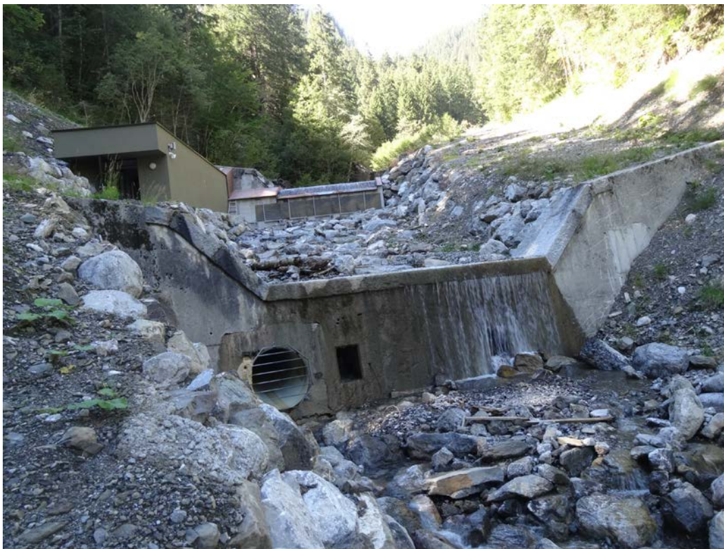
Abbildung 6: Bestehende Wildbachsperre mit Auslauf des Spülkanals (grosses Rohr)
