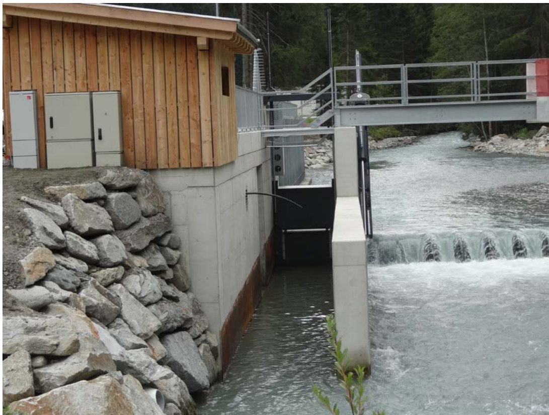
Abbildung 7: Detailansicht Dotier-/Spülschütze vom Unterwasser
