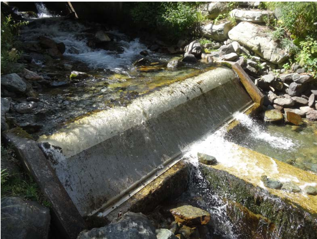
Abbildung 4: Nahaufnahme des Coanda-Rechens
