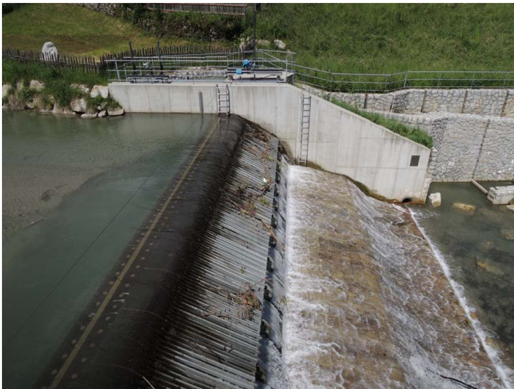
Abbildung 4: Detailansicht Grizzly Power Optimus mit Grobrechen, im Bildhintergrund die Fischtreppe
