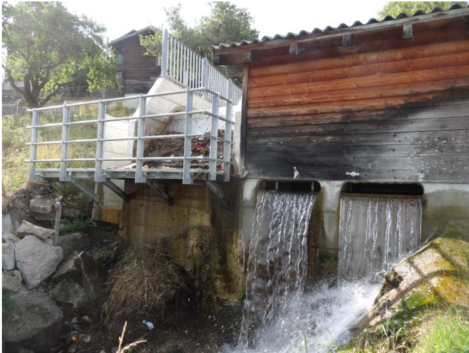
Abbildung 3: Sicht vom Unterwasser. Coanda-Rechen links, Überlauf rechts
