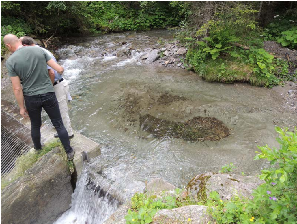
Abbildung 5: Leichter Gewässerstau oberhalb der Fassung
