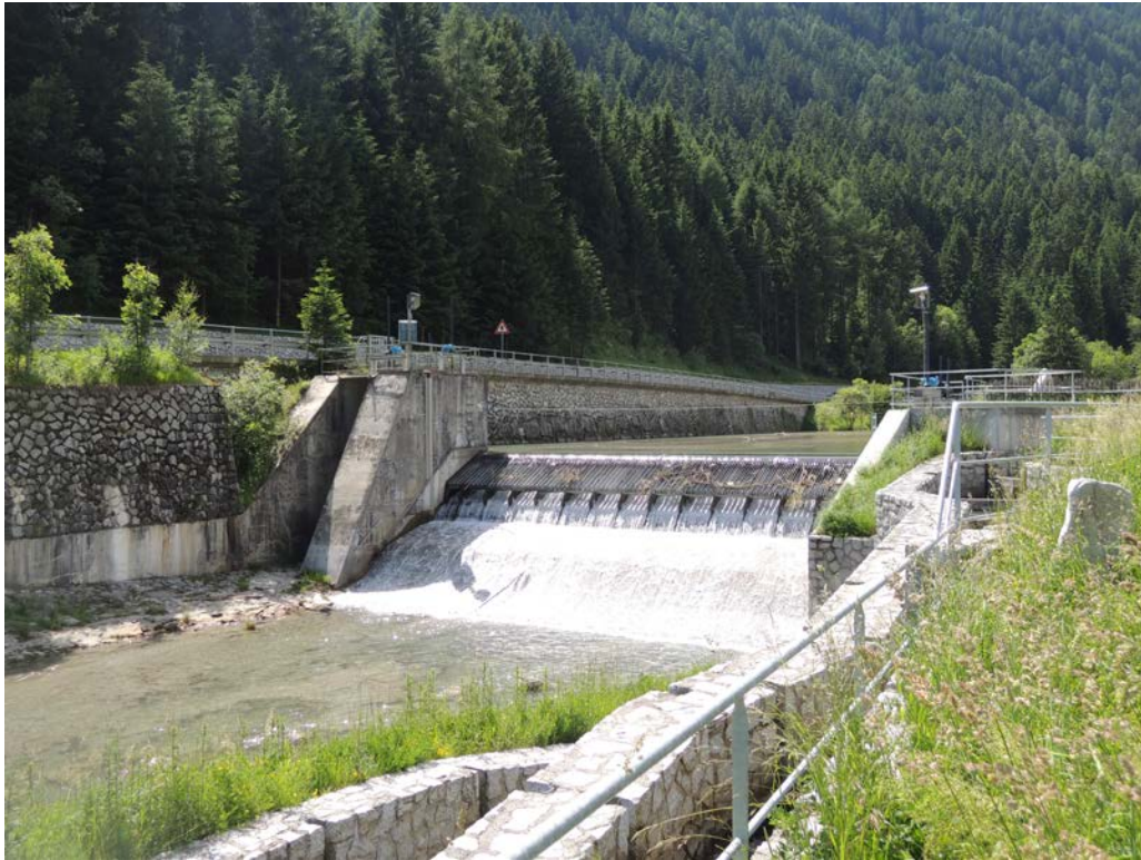
Abbildung 1: Übersicht. Fassung in bestehende Sperre integriert
