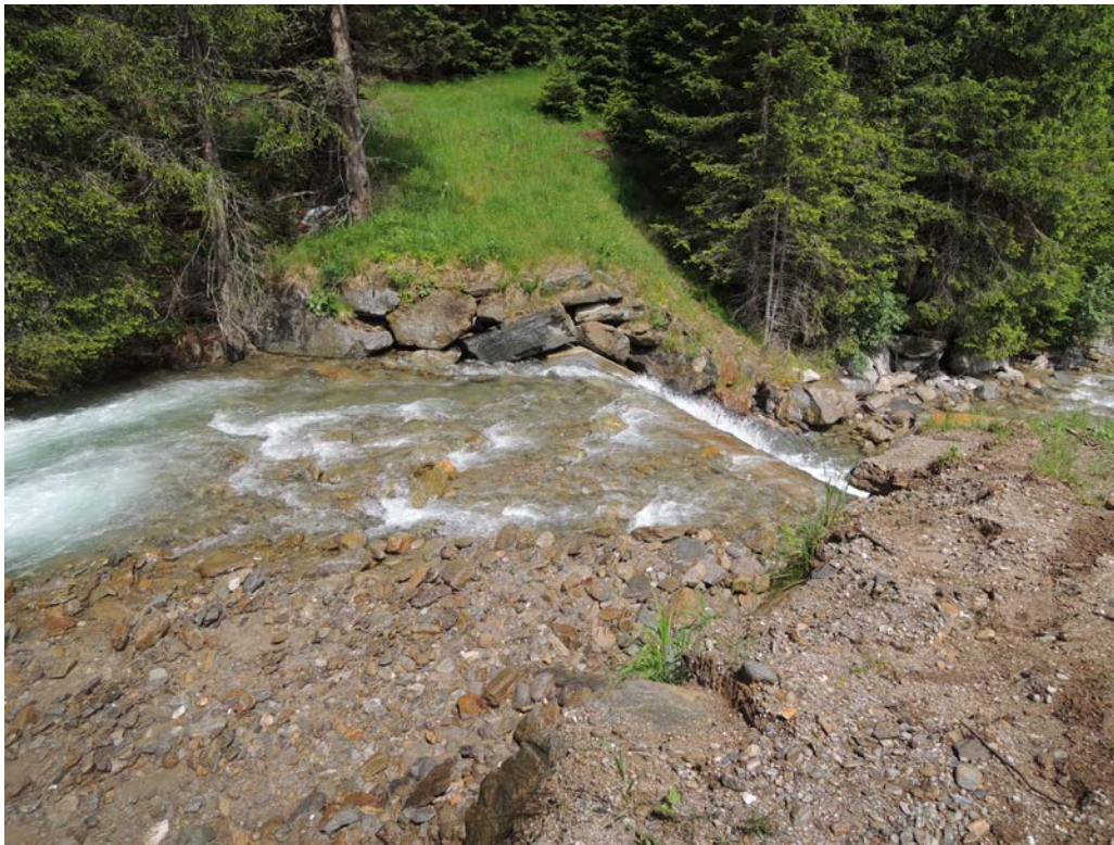
Abbildung 3: Blick vom Oberwasser. Vollständige Auflandung mit Geschiebe, unregelmässige Anströmung gut sichtbar
