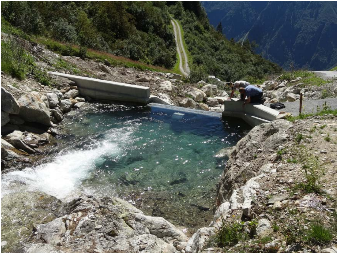
Abbildung 3: Sicht vom Oberwasser mit kleinem Staubecken, Tiefe ca. 1.5 m
