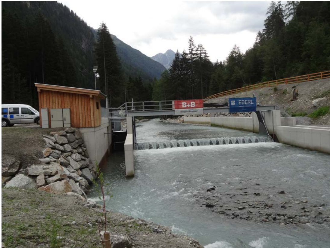
Abbildung 3: Blick vom Unterwasser bei abgesenktem Staupegel. Links Seitenentnahme mit Coanda-Rechen sowie Dotier-/Spülschütze, rechts Vertical slot Fischpass
