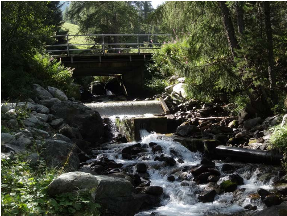
Abbildung 6: Wasserableitung mit schwarzem PE-Rohr (rechts)
