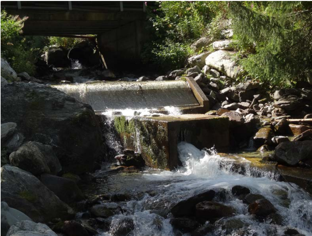
Abbildung 3: Sicht vom Unterwasser. Coanda-Rechen ohne Schutzrechen
