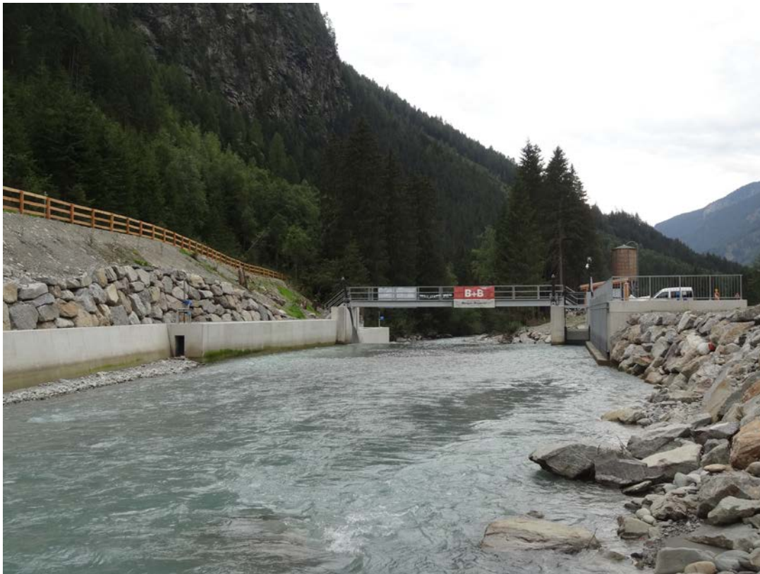
Abbildung 2: Blick vom Oberwasser bei um ca. 1 m abgesenktem Staupegel. Rechts Seitenentnahme mit Coanda-Rechen, links Vertical slot Fischpass mit Ausstiegsöffnung
