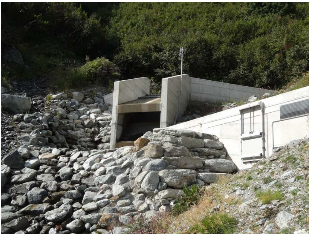
Abbildung 6: Sandfang mit Spülschütze (rechts)
