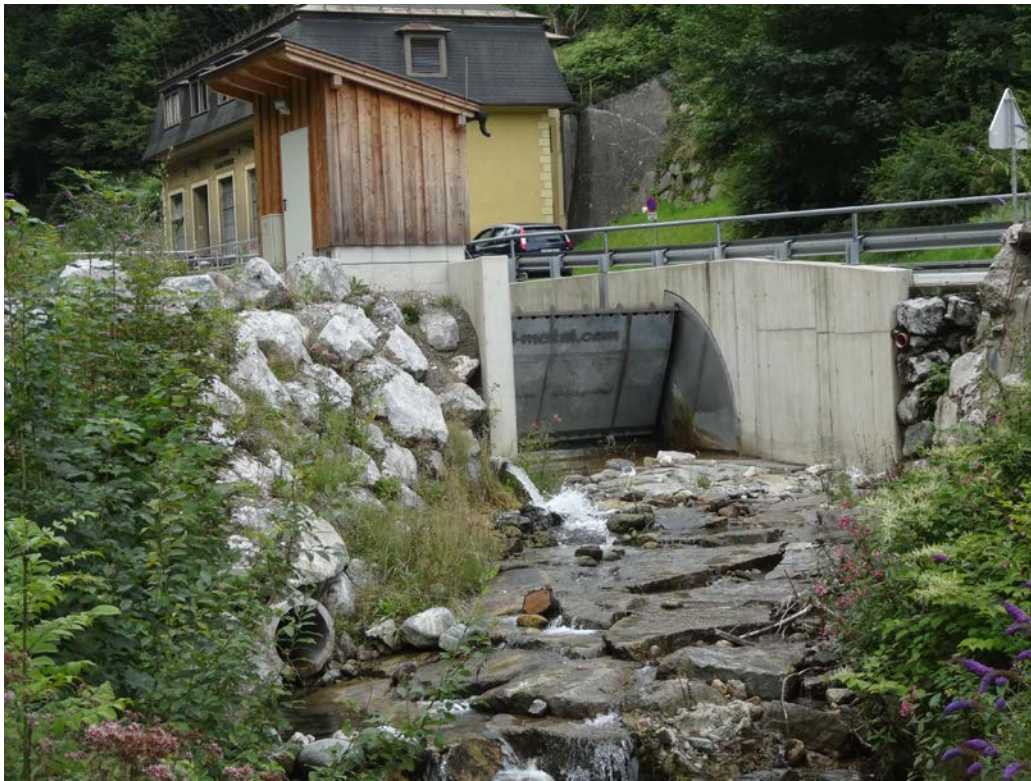
Abbildung 7: Kasbach mit Restwasserdotation von 30 l/s. Blick vom Unterwasser
