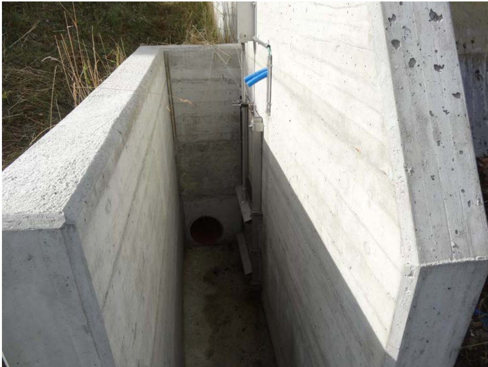
Abbildung 6: Detailansicht der Spülrinne, rechts Spülschütze
