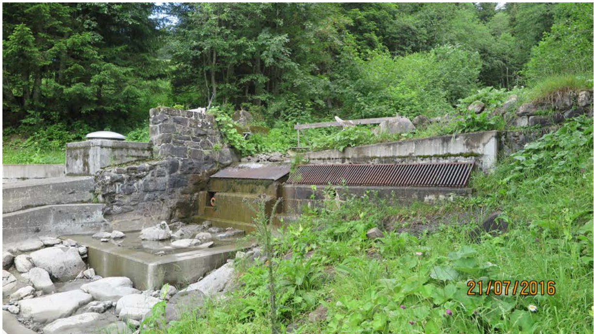
Abbildung 1: Übersicht, links das Fassungsgebäude mit Einstieg über Brunnendeckel
