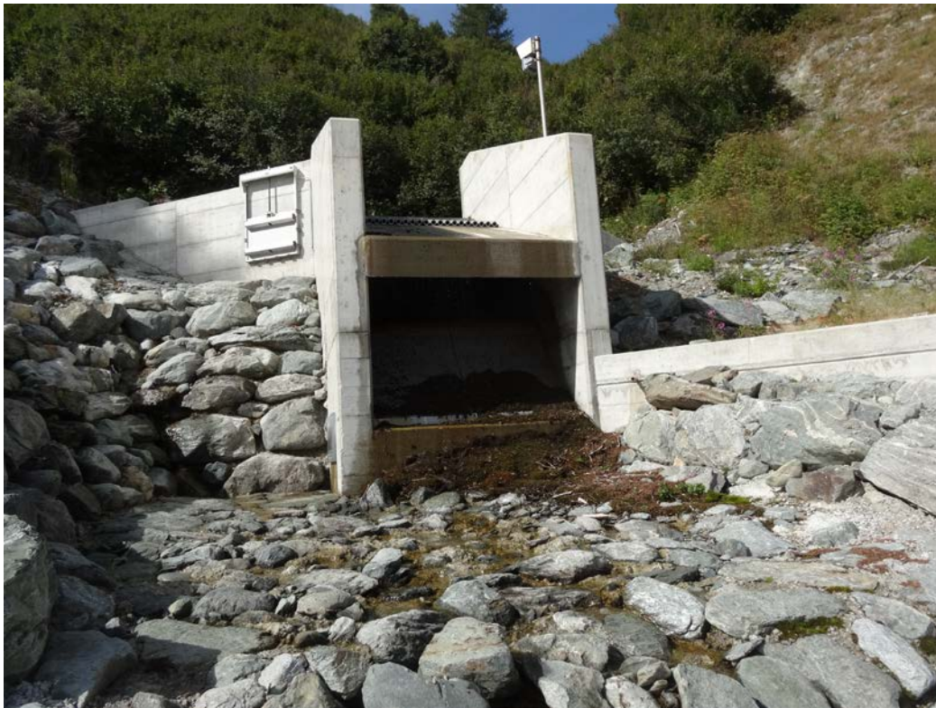
Abbildung 3: Sicht vom Unterwasser. Spülschütze links im Bild
