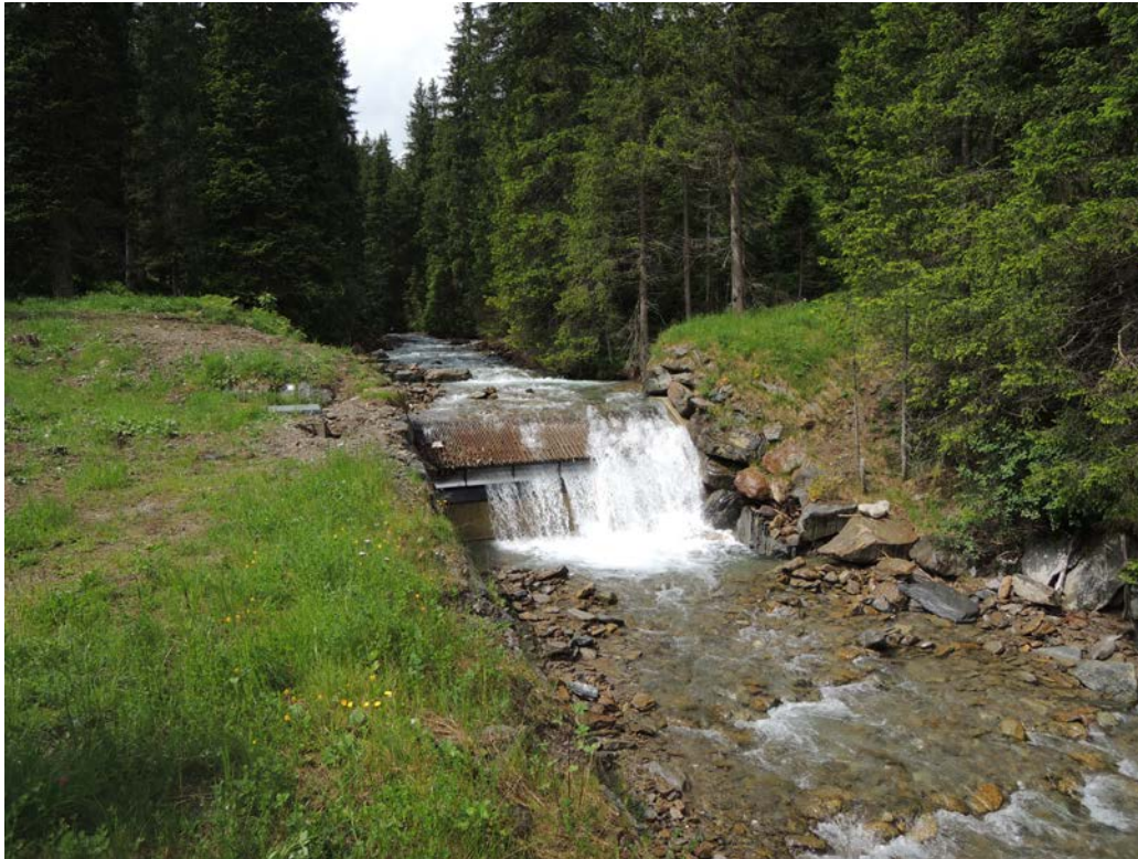
Abbildung 1: Übersicht der Fassung. Ungleichmässige Anströmung
