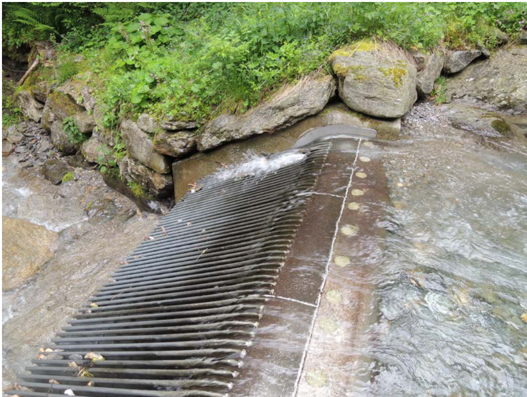
Abbildung 3: Detailansicht Grizzly Poewer Optimus mit Grobrechen
