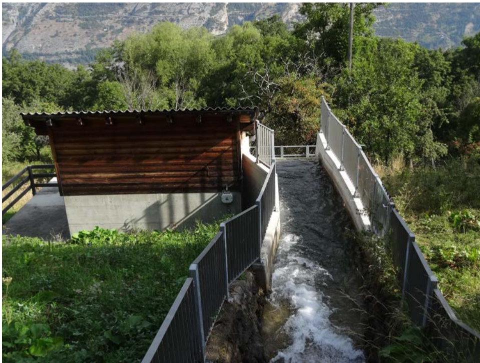
Abbildung 2: Sicht vom Oberwasser mit betoniertem Einlaufkanal
