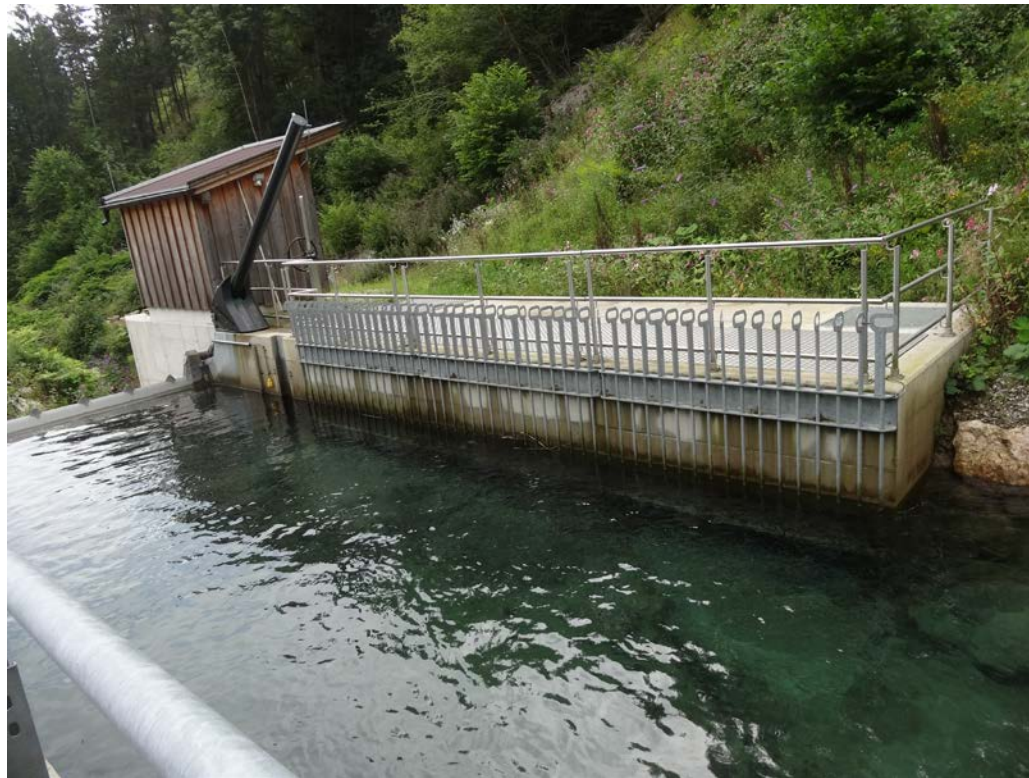
Abbildung 5: Seitlicher Einlauf in Coanda-Rechen mit Tauchwand und Grobrechen mit senkrechten Stäben
