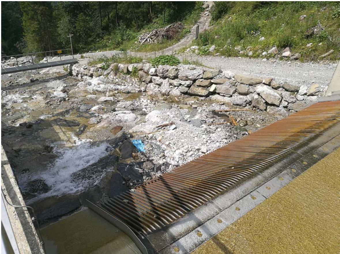
Abbildung 4: Sicht Richtung Unterwasser
