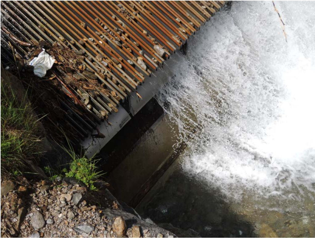
Abbildung 5: Restwasserdotation ab Coanda-Rechen in Bachmitte
