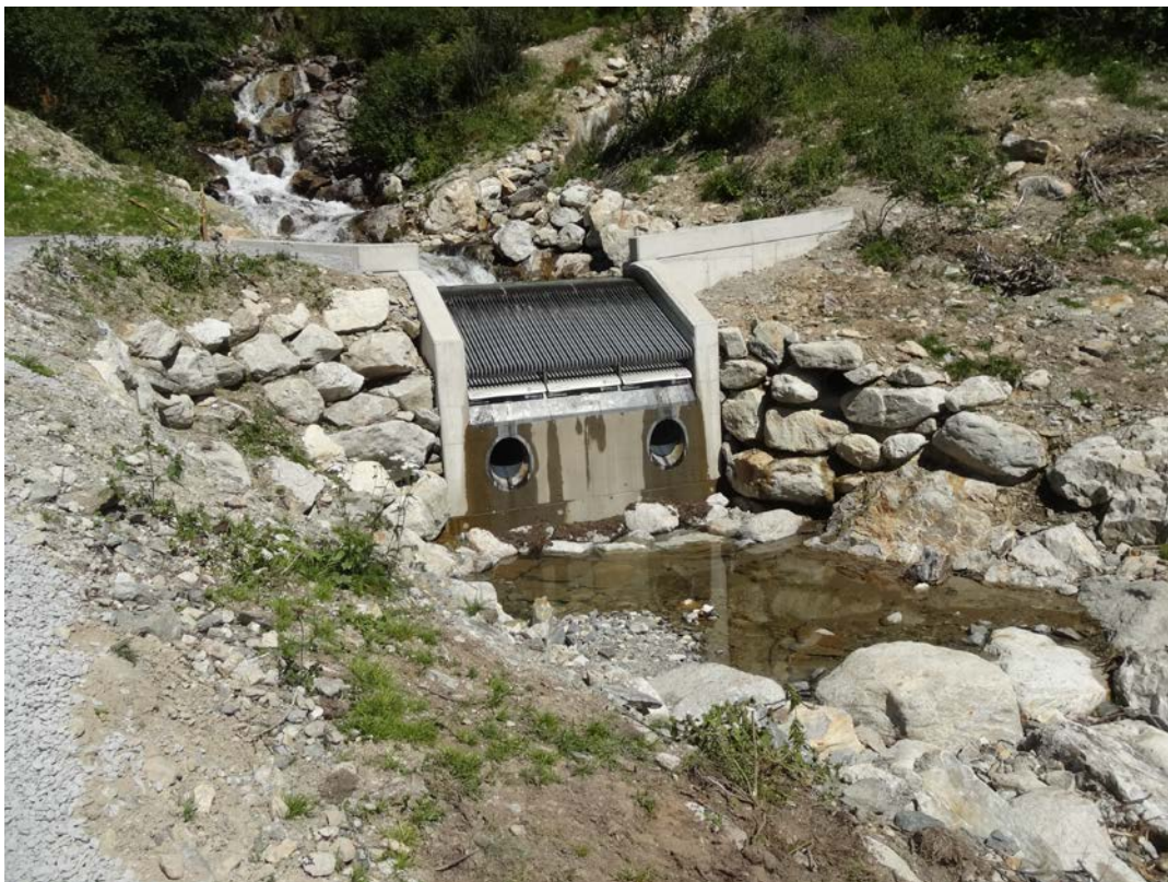
Abbildung 2: Sicht vom Unterwasser. Symmetrische Fassungsanlage mit beidseitigen Flügelmauern; gut sichtbar 2 Spülrohre DN 60 cm
