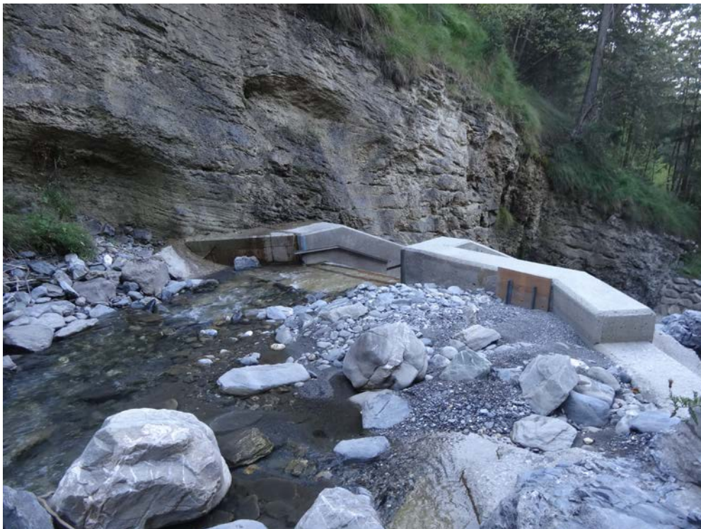
Abbildung 2: Sicht vom Oberwasser. Das Brett schliesst den Einlauf des Spülrohrs ab, Vertiefung rechts für Geschiebedurchgang
