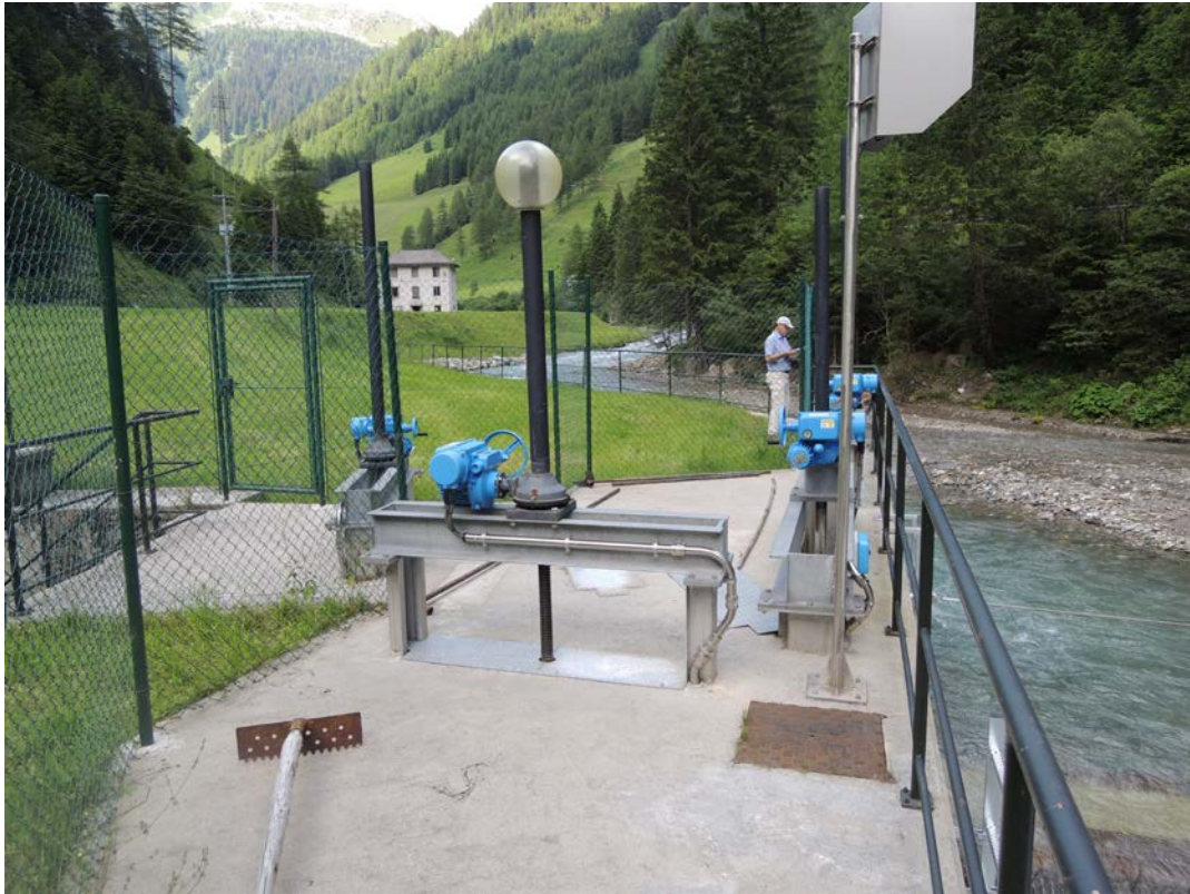
Abbildung 7: Einlauf- und Spülschützen mit unterirdischem Triebwasserkanal, rechte Bachseite
