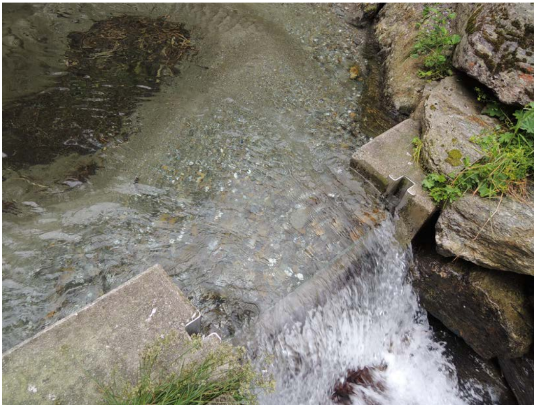
Abbildung 4: Dynamische Restwasserdotation mit kleiner Öffnung in Wehrschwelle
