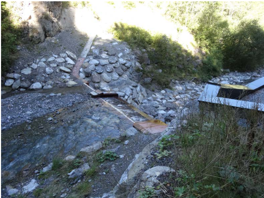
Abbildung 2: Sicht vom Oberwasser. Die Fassung ist in eine bestehende Wildbachsperre integriert
