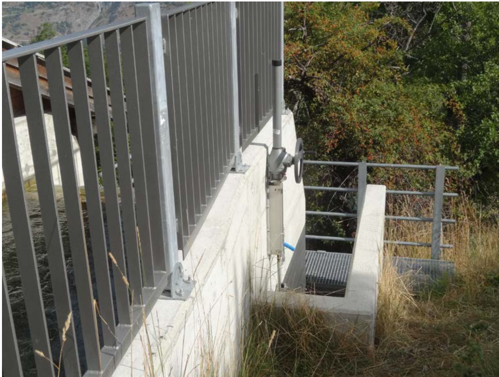
Abbildung 5: Spülrinne rechterhand des Coanda-Rechens mit manuell bedienbarer Spülschütze
