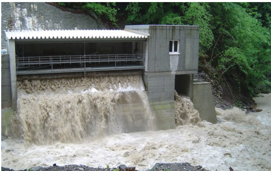
Europaweit grösster Coanda-Rechen an der Samina, EW Frastanz, Vorarlberg A. Kapazität 2660 l/s. Fabrikat: Dulas Ltd, Schweizer; Vertrieb: Firma Andaco GmbH.
