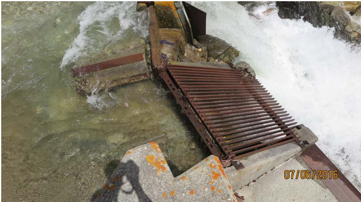
Abbildung 2: Anströmbereich und Schutzrechen
