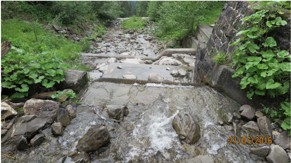
Abbildung 3: Blick Richtung Unterwasser
