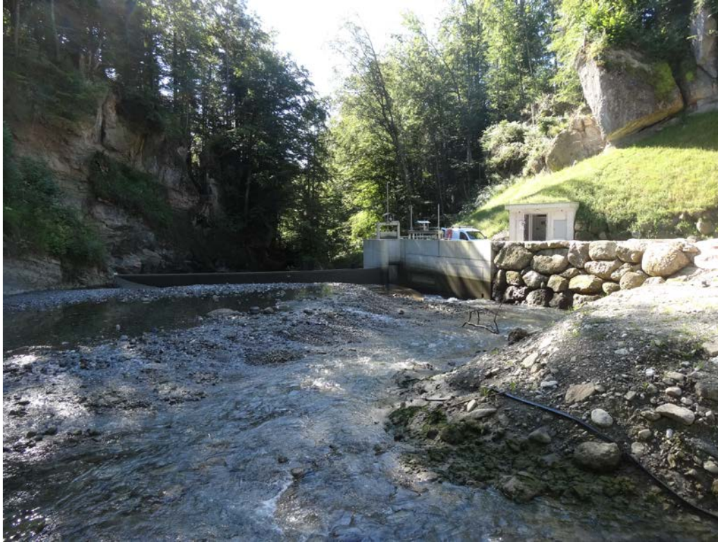
Abbildung 1: Übersicht. Links kleine Stauwehrmauer, rechterhand die Fassung und Spülschütze bzw. Kiesschleuse, grosse Geschiebeablagerungen
