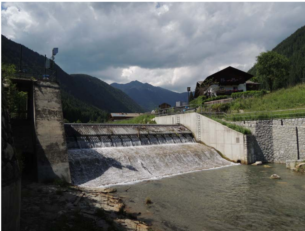
Abbildung 2: Blick vom Unterwasser. Links im Bild bzw. im Halbschatten der Spülkanal, rechts im Bild die Bruchsteinmauerwerk verkleidete Fischtreppe
