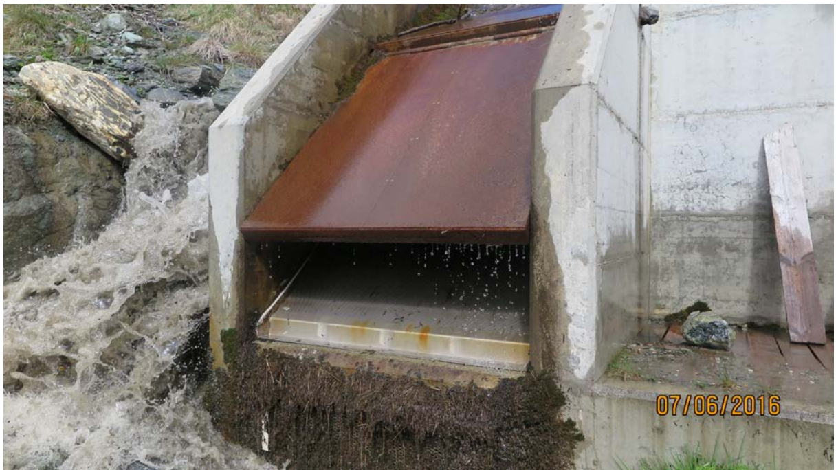
Abbildung 4: Detail Hauptfassung Prascherbach: Schutzblech über Coanda
