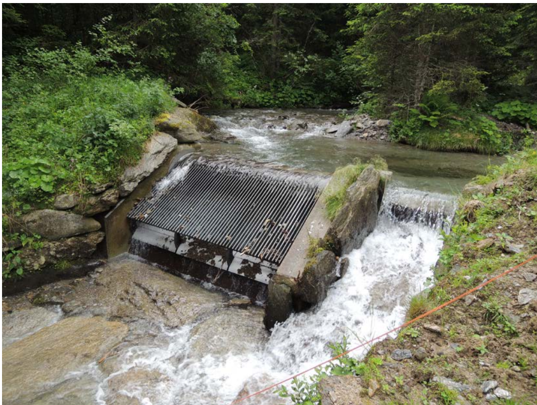
Abbildung 2: Blick vom Unterwasser, mit Restwasserdotation rechts im Bild
