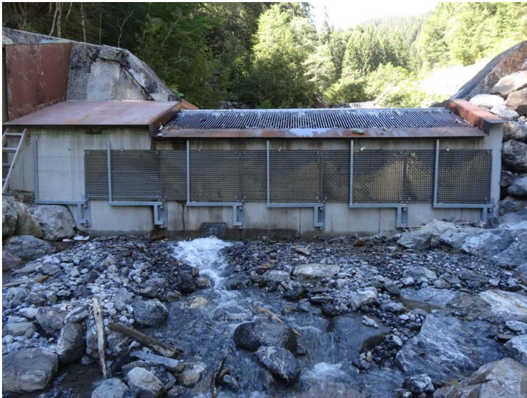
Abbildung 3: Sicht vom Unterwasser mit Restwasserdotation mittels Blende links der Bildmitte. Das Gitterrost ist abklappbar und dient dem Unterhalt
