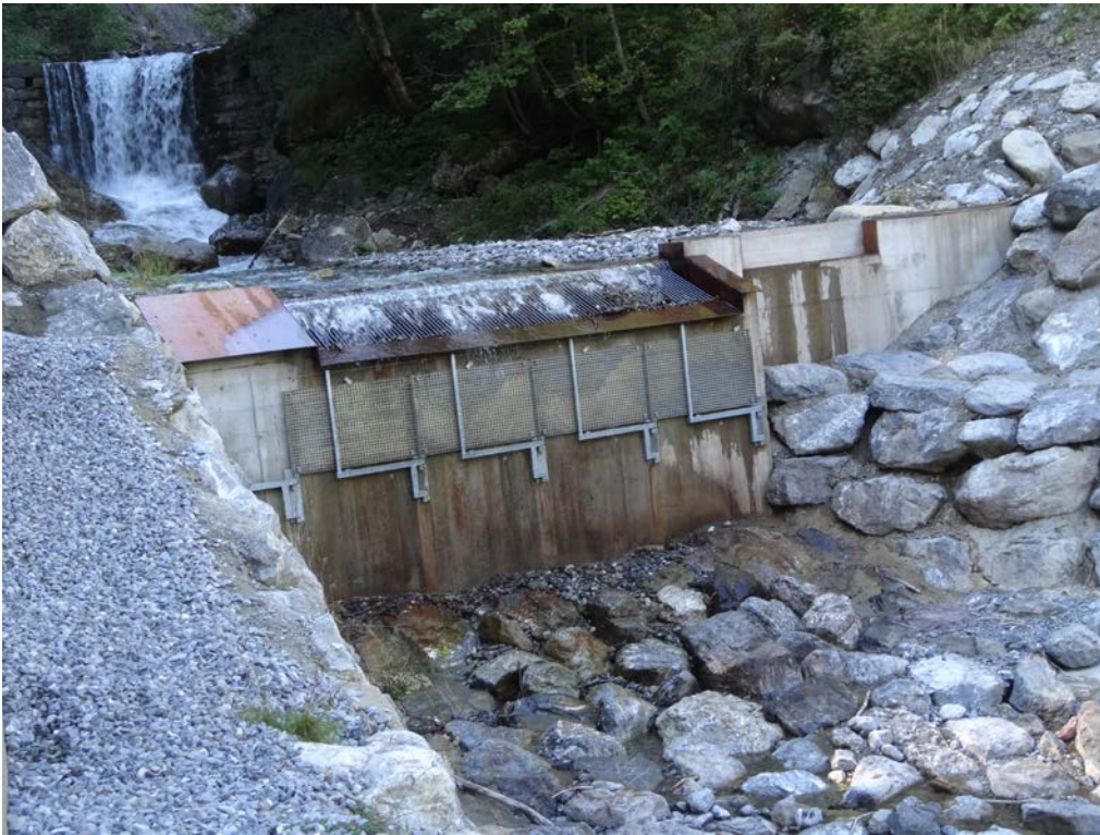
Abbildung 3: Sicht vom Unterwasser. Das Gitterrost dient dem Unterhalt
