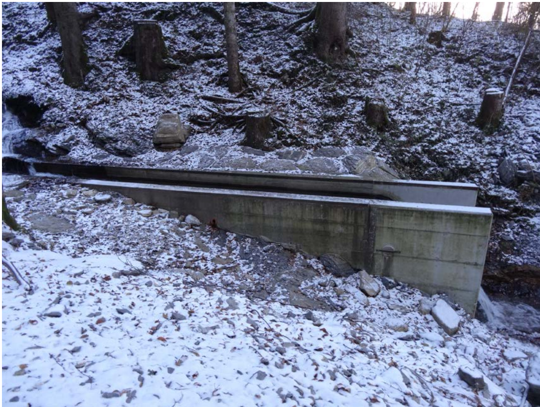
Abbildung 5: Seitenansicht des Anströmkanals aus Ortbeton
