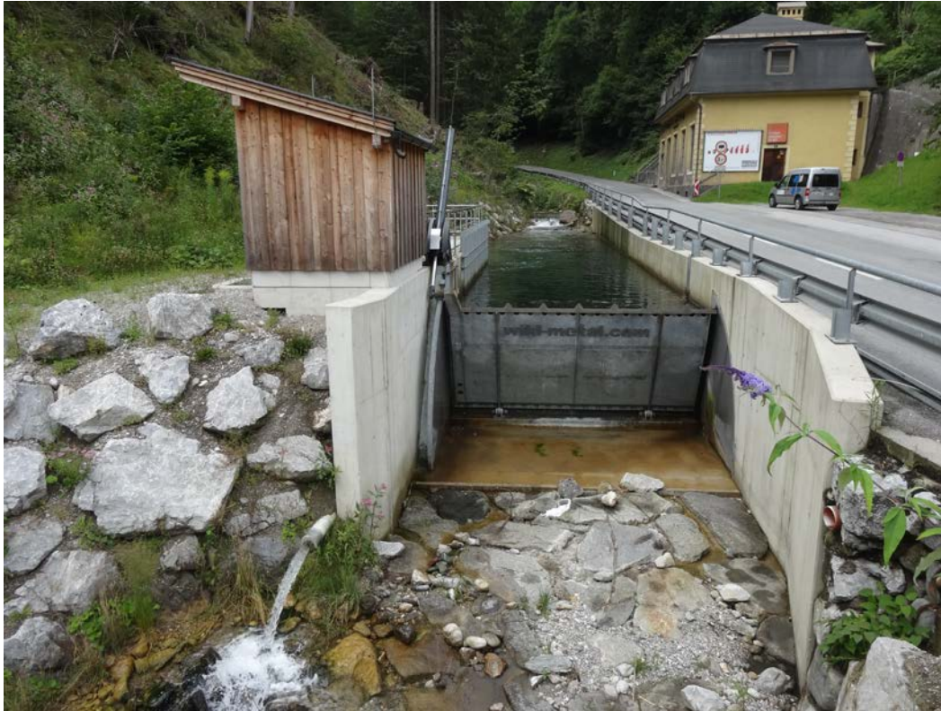
Abbildung 3: Blick vom Unterwasser. Gewässerstau mit Klappenschütze. Seitenentnahme mit Coanda-Rechen links im Bild, Restwasserdotation mit Rohr links im Bild
