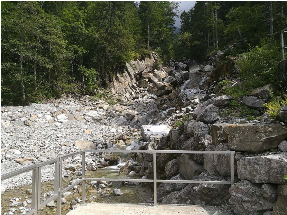
Abbildung 3: Sicht Richtung Oberwasser
