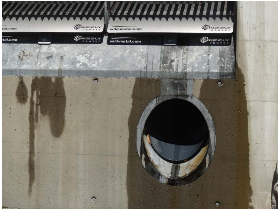
Abbildung 5: Detailansicht Spülrohr DN 60 cm; Sicht vom Unterwasser
