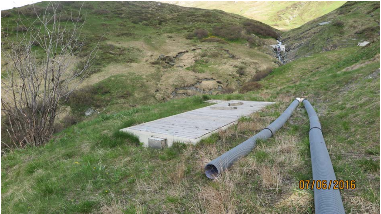
Abbildung 10: Sammelbecken vor Triebleitung für sämtliche Fassungen, im Hintergrund zwei Fassungen Prascherbach
