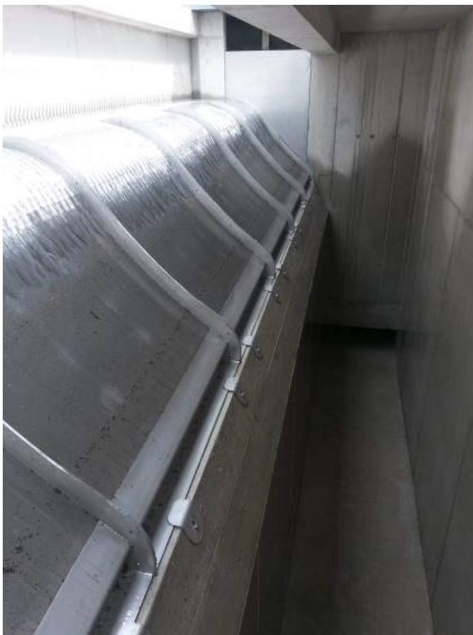
Abbildung 4: Detailansicht Coanda-Rechen (Foto: Eberl ZT GmbH)
