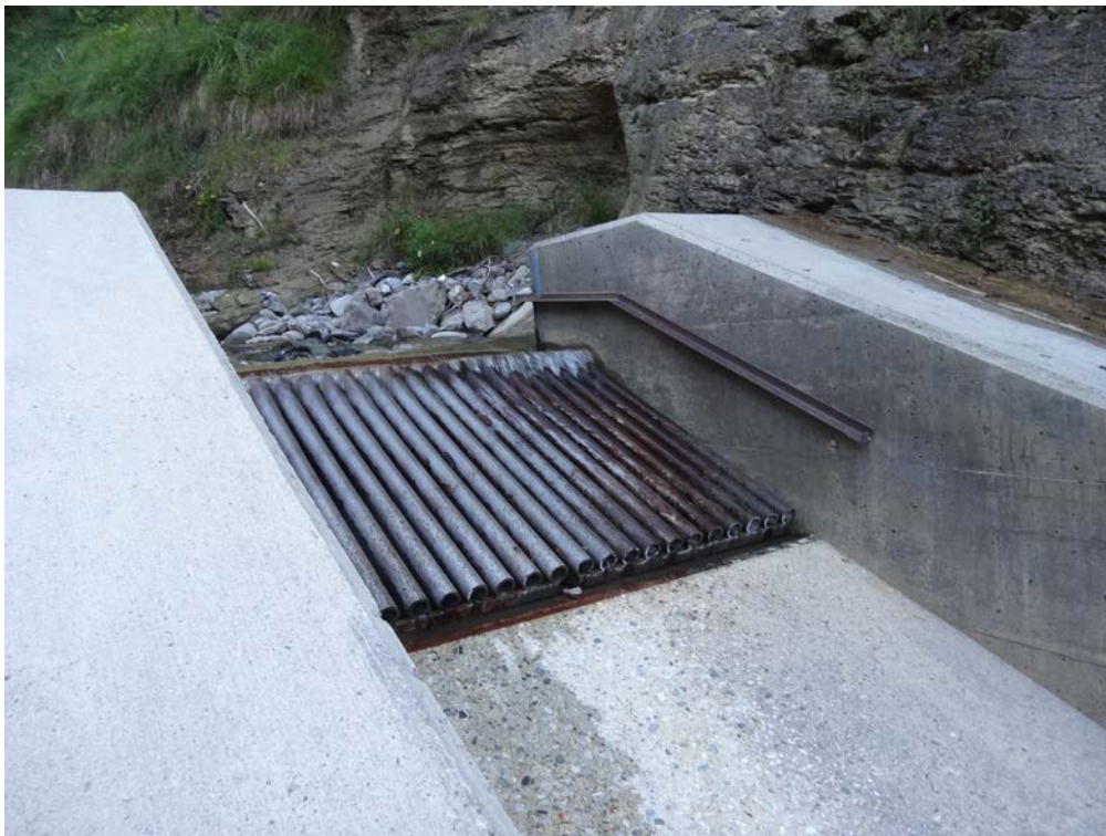
Abbildung 4: Obenliegender Schutzrechen (Eigenkonstruktion)
