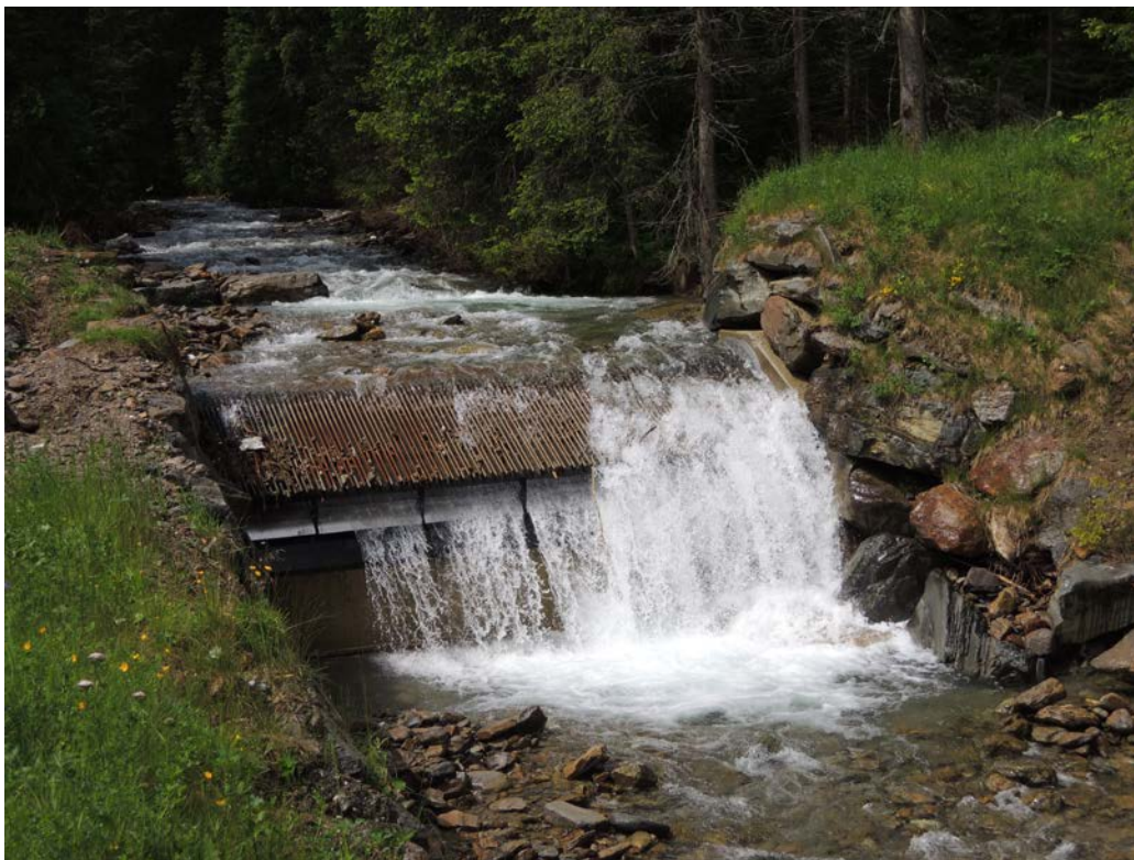
Abbildung 2: Nahaufnahme. Blick vom Unterwasser. Heller Coanda-Rechen unter dem Schutzrechen ersichtlich
