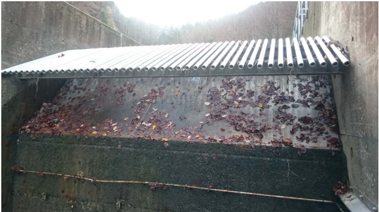
Abbildung 4: Coanda-Rechen und Grobrechen
