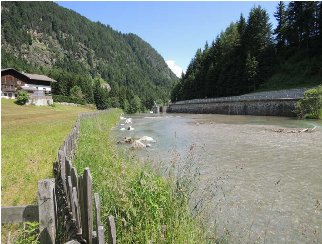
Abbildung 3: Blick vom Oberwasser. Gewässerstau mit starker Verlandung des Staureaums
