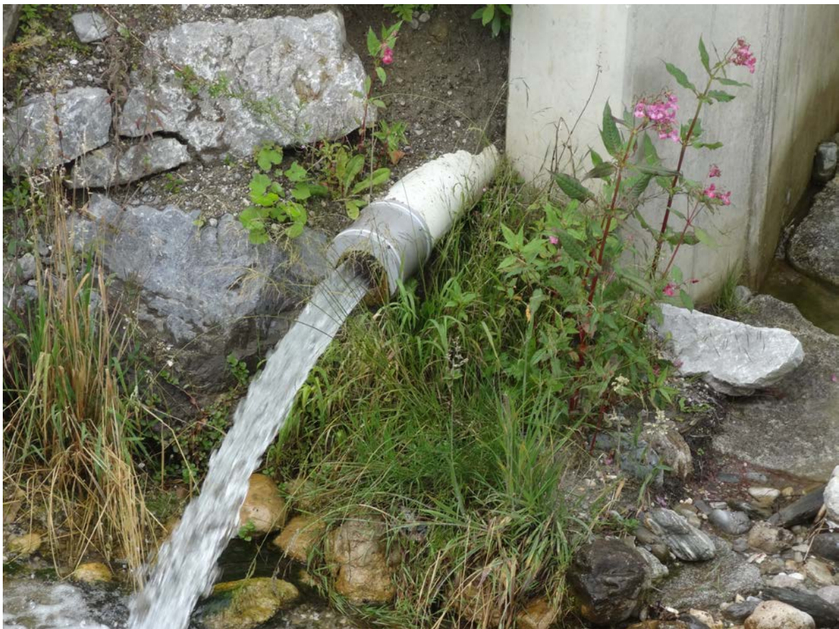
Abbildung 8: Detail der Restwasserdotation von 30 l/s
