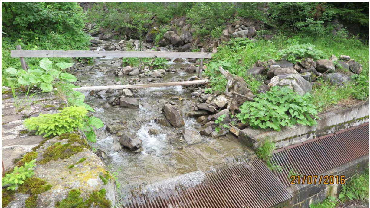
Abbildung 2: Blick Richtung Oberwasser
