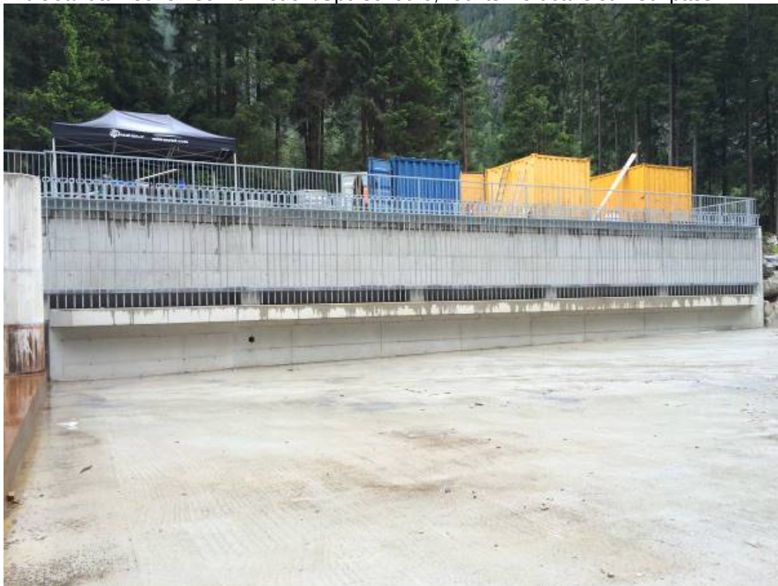
Abbildung 4: Bauzustand der Seitenentnahme mit Tauchwand, senkrechtem Grobrechen und dahinterliegendem Coanda-Rechen mit 5 Segmenten (Foto: Eberl ZT GmbH)
