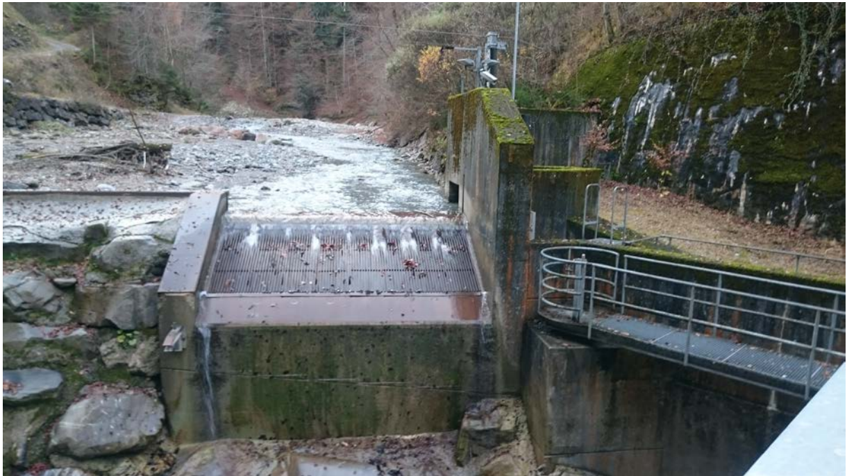
Abbildung 5: Tirolerwehr vor Leitkanal
