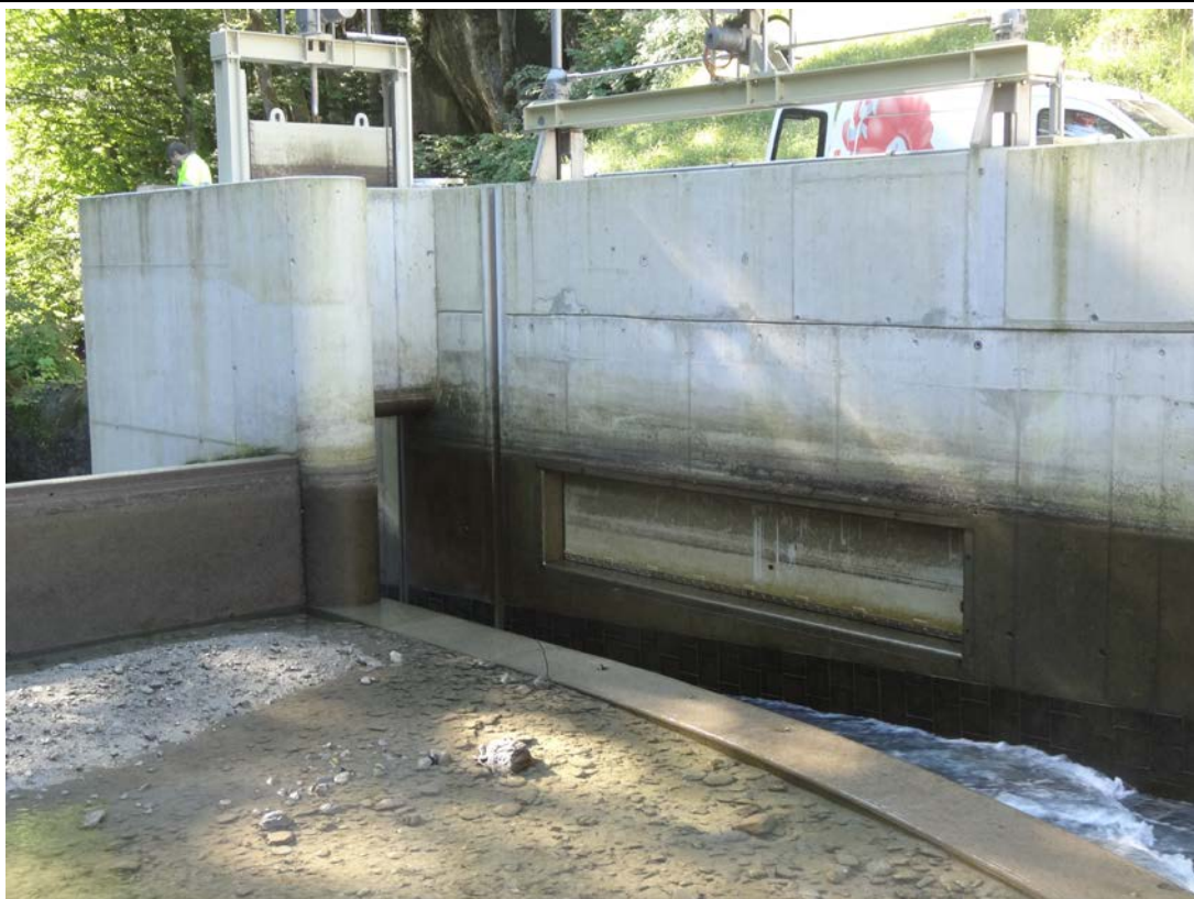
Abbildung 4: Rechteckige Seitenentnahme (Beton-Schlitz) mit geschlossener Einlaufschütze. Kein KW-Betrieb, da aktuelle Abflussmenge kleiner als 250 l/s. Der Stauspiegel bei KW-Betrieb liegt etwa auf der Höhe der dunklen Fläche.
