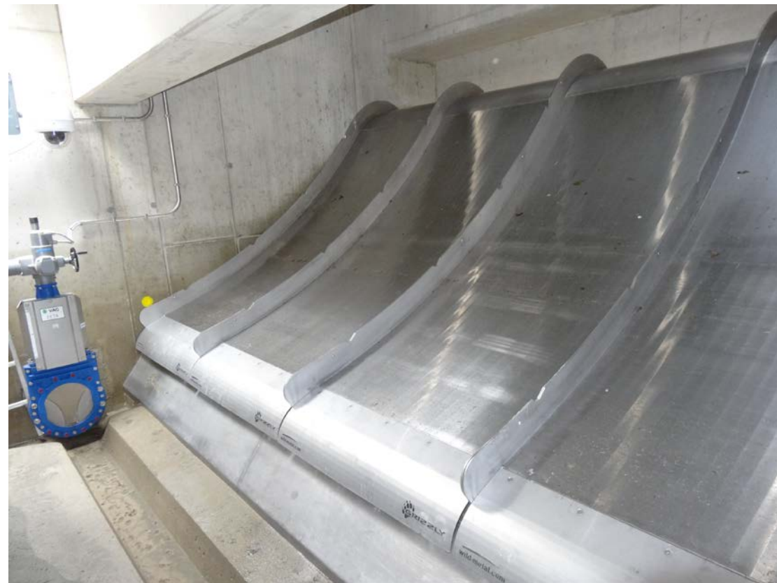
Abbildung 5: Detailansicht Coanda-Rechen mit Spülrinne
