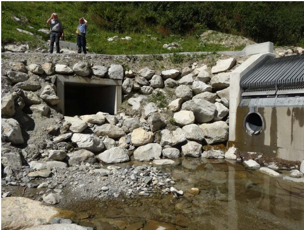
Abbildung 7: Rechteckiger Kanal-Notüberlauf am rechten Ufer mit Dotierwasserabgabe (5 l/s Restwasser)
