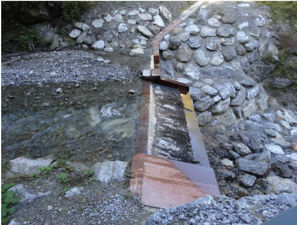
Abbildung 5: Seitliche Ansicht des Grobrechens in Form eines Tirolerwehrs
