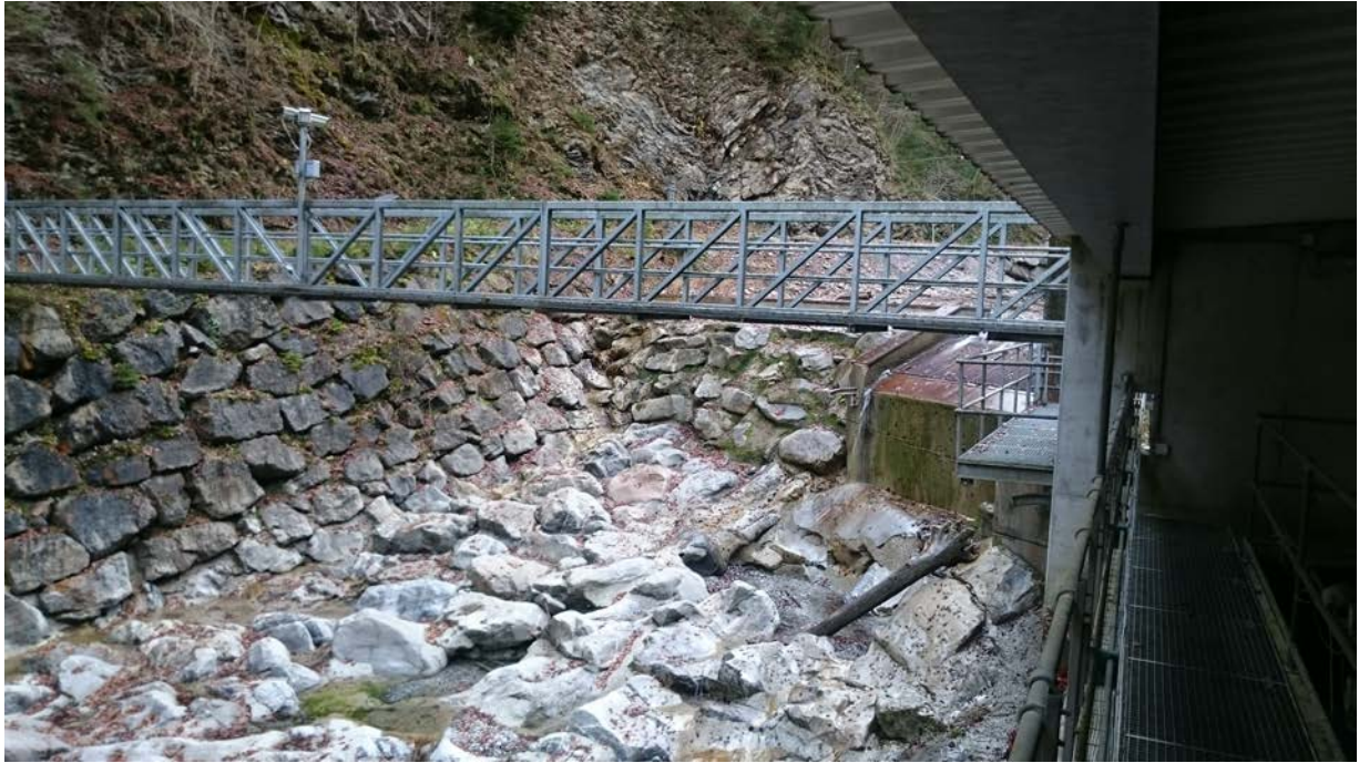
Abbildung 3: Sicht vom Unterwasser
