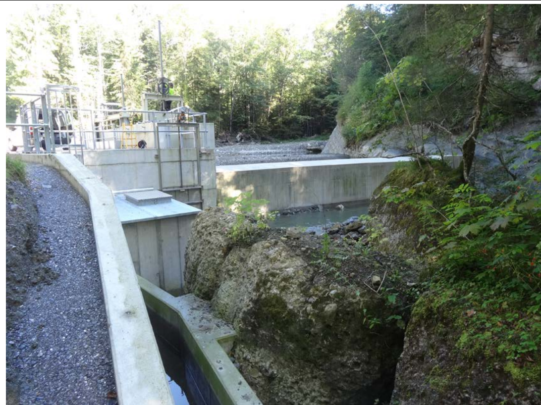
Abbildung 3: Sicht vom Unterwasser. Gut sichtbar die niedrige Stauwehrmauer, links im Vordergrund die Fischabstiegsrinne bzw. der Spülkanal beim Coanda-Rechen
