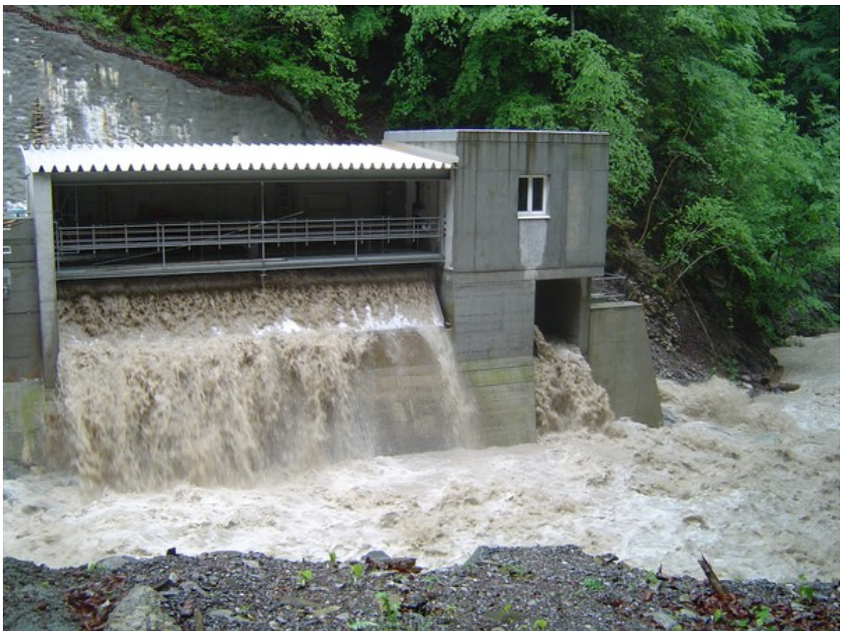
Abbildung 6: Übersicht bei Hochwasser (Bild: E-Werke Frastanz)
