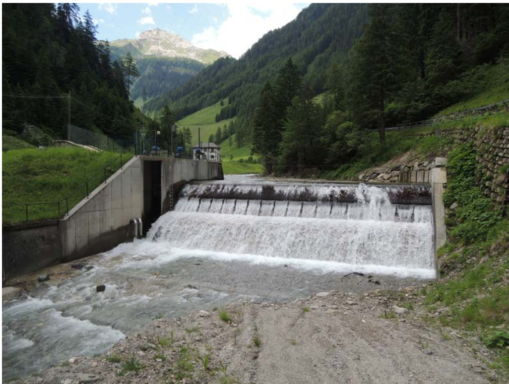
Abbildung 2: Blick von unten mit der mehrere Meter hohen Wehrschwelle
