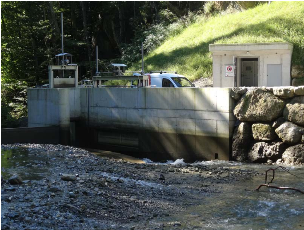
Abbildung 2: Sicht vom Oberwasser am 25.8.2016. Kein KW-Betrieb, abgesenkter Wasserspiegel. Das Wasser fließt durch die offene Spülschütze
