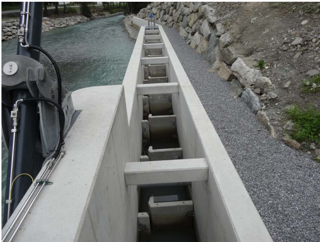
Abbildung 8: Vertical slot Fischpass (nicht im Betrieb). Blick flussaufwärts
