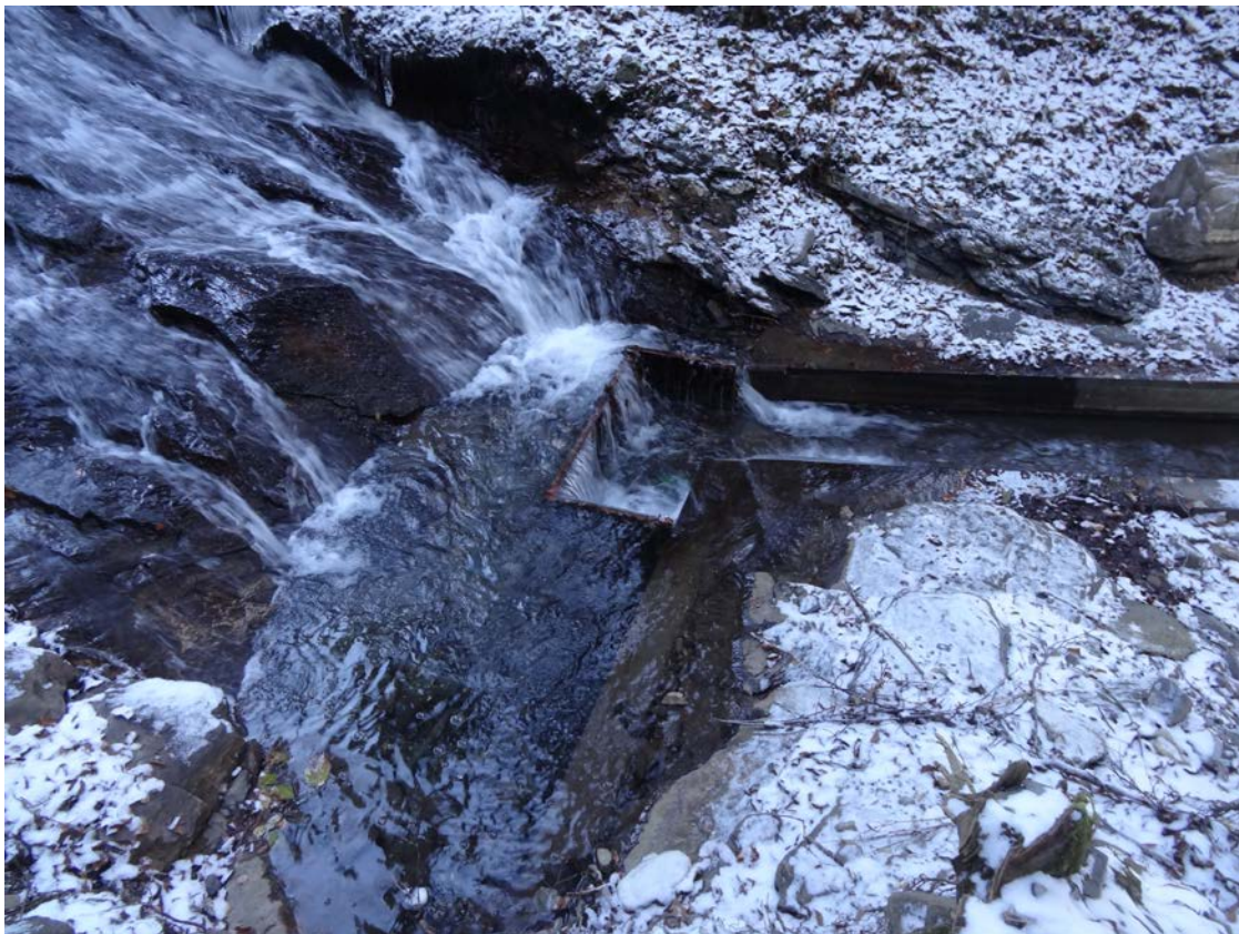
Abbildung 4: Kleines Tosbecken vor dem Anströmkanal
