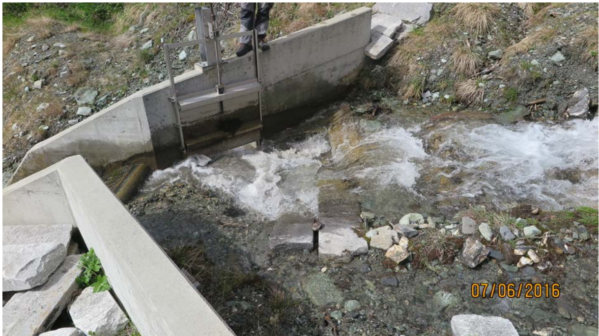
Abbildung 2: Hauptfassung Prascherbach, Sammelbecken und Spülklappe
