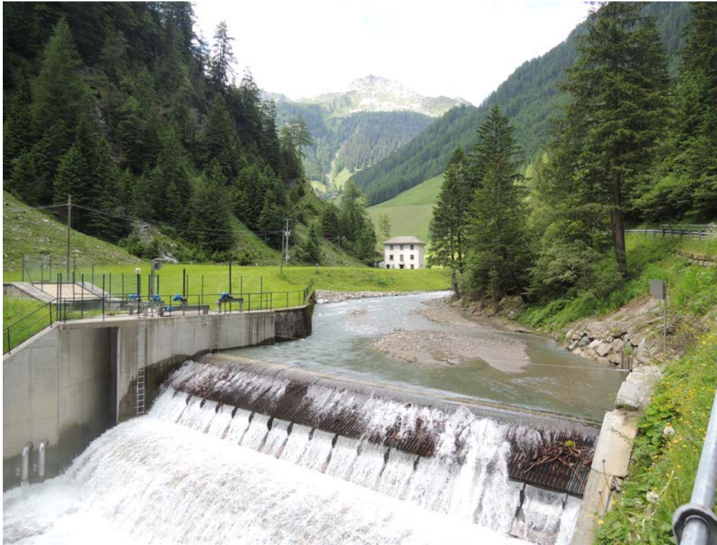
Abbildung 1: Übersicht. Fassung integriert in bestehende Wildbachsperre
