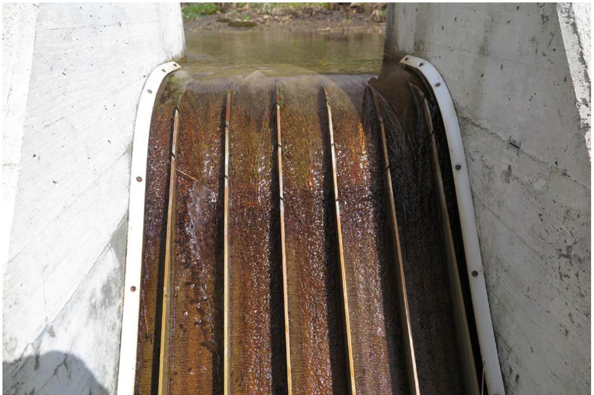
Abbildung 8: Fassung Prascherbach, Detail Verstärkungsrippen mit Schlitzen, sämtliche kleinen Fassungen sind ähnlich ausgestaltet
