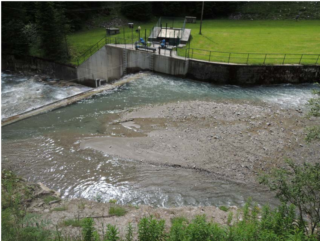
Abbildung 3: Blick von oben. Grössere Geschiebeablagerungen
