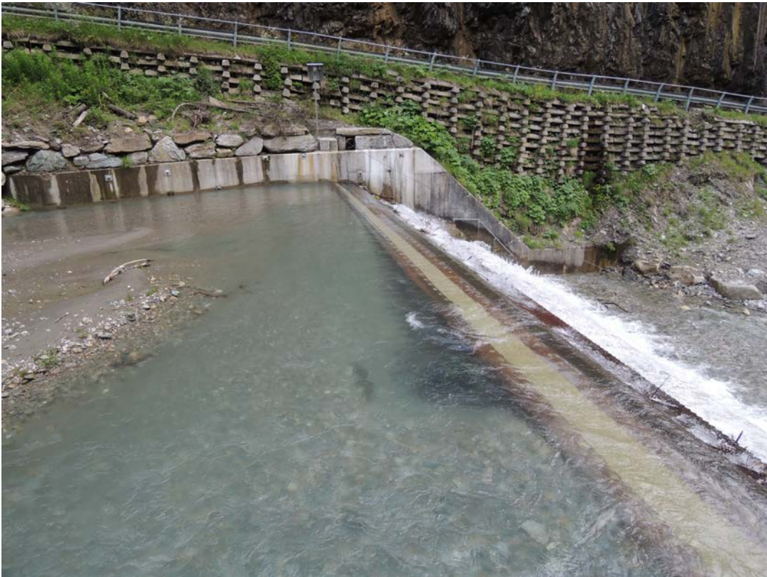
Abbildung 5: Erkennbare Spülrinne oberhalb der Fassungsschwelle quer zum Fluss
