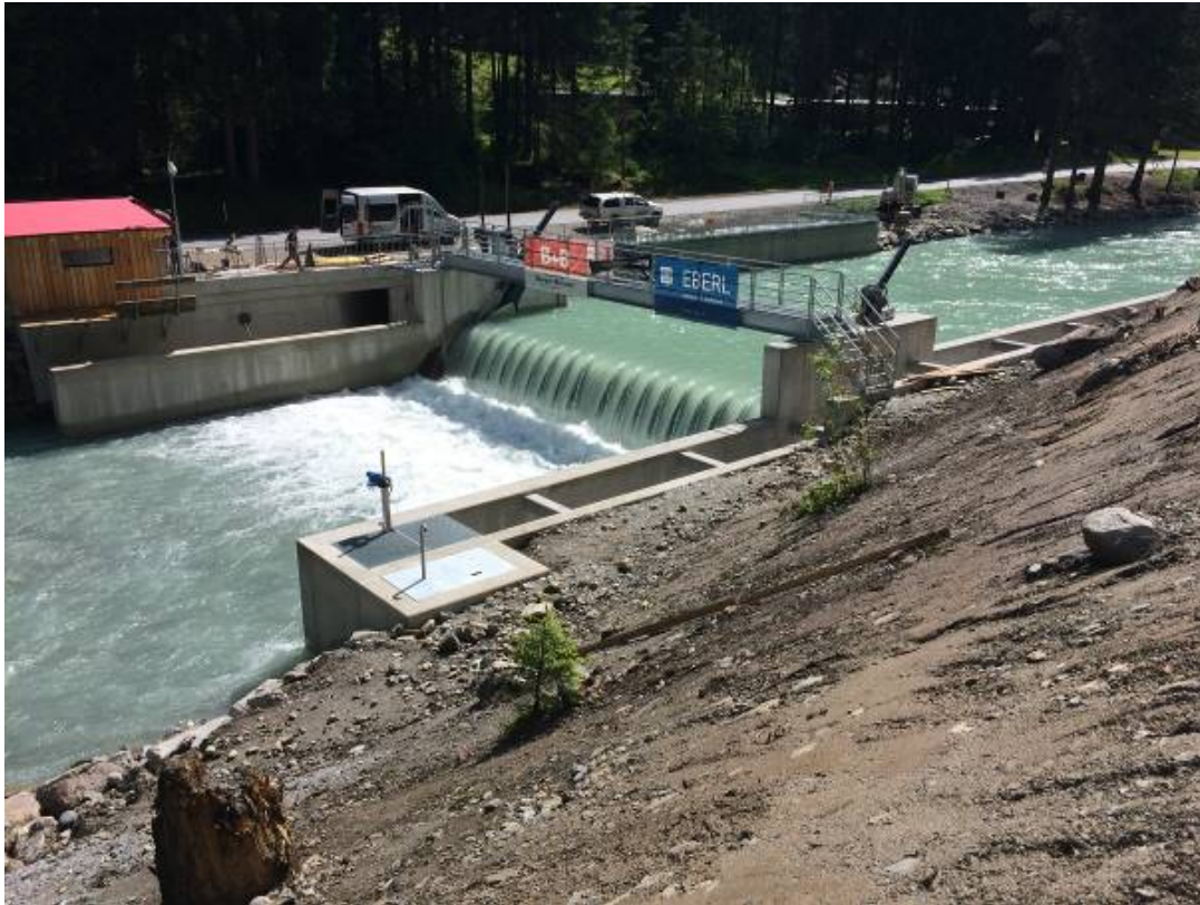
Abbildung 1: Gesamtansicht der Wasserrfassung (Foto: Eberl ZT GmbH)
