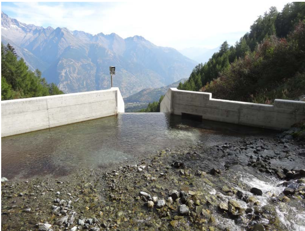
Abbildung 2: Sicht vom Oberwasser. Öffnung rechts mit Spülschütze
