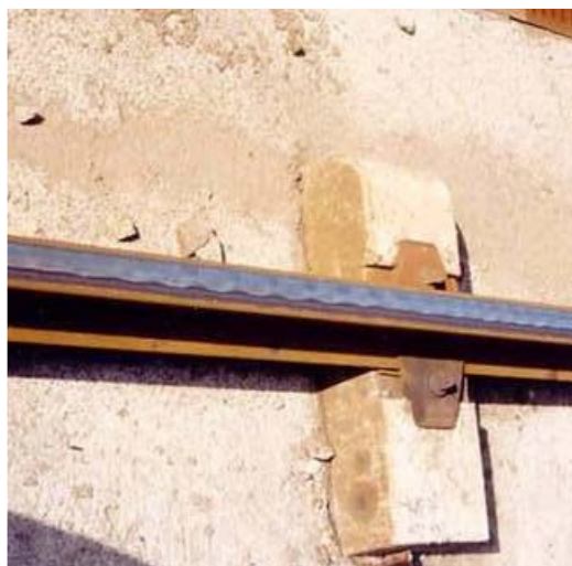
Abbildung 2-1 Rail corrugation aus [27]
