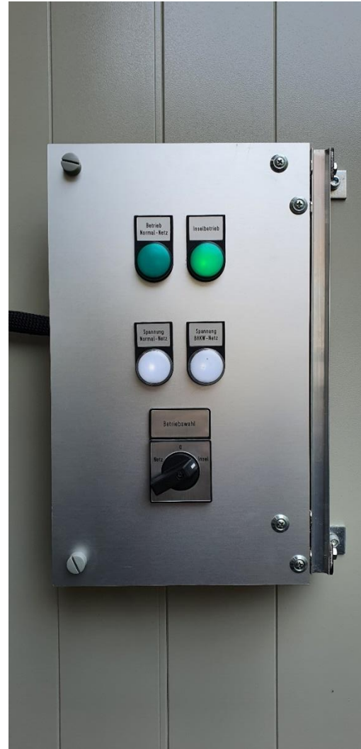
Abbildung 7: Hauptverteilung und Schalter Betriebsmodus auf Inselbetrieb
