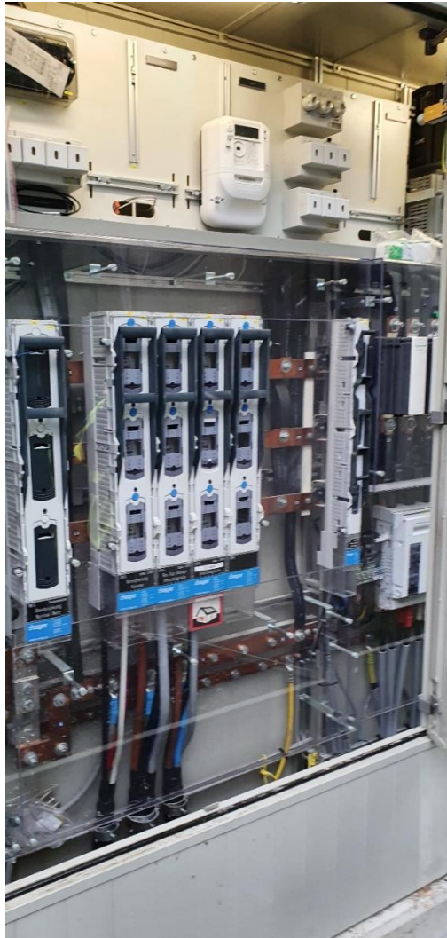
Abbildung 7: Hauptverteilung und Schalter Betriebsmodus auf Inselbetrieb
