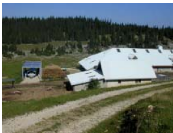
Fig. 18: Installation autonome de l'alpage des Amburnex (Photo: Service industriels de la Ville de Lausanne)
