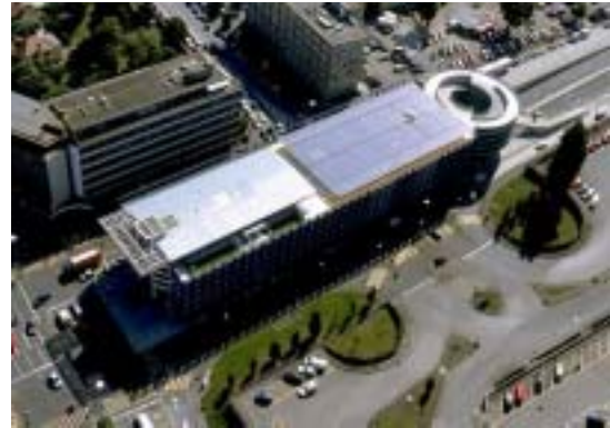
Fig. 10: Intégration en toiture Parking de l'Etoile, Genève (Photo: Sunwatt Bio Energie SA)
