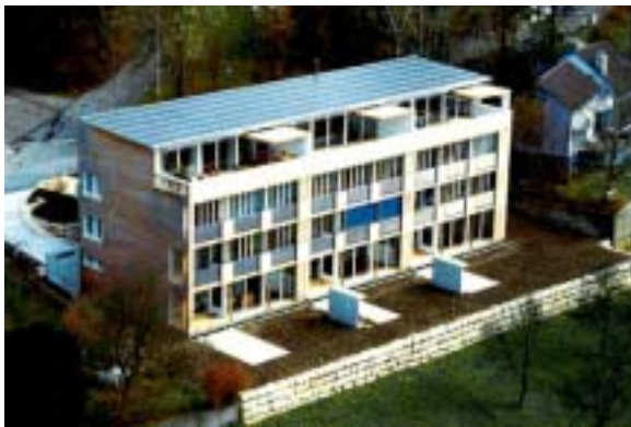
Fig. 9: Intégration du photovoltaïque en toiture Sunny Woods (Photo: Bureau d'architecture Beat Kämpfen)
