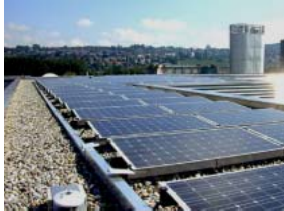
Fig. 23: Installation de toiture plate d'IBM, à Zurich (Photo: NET SA)
