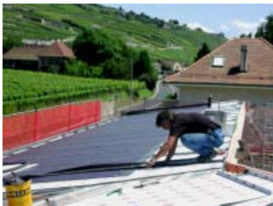
Fig. 11: Montage du système d'intégration PV en toiture à cellules amorphes triples 'Freestyle®' à Lutry (Photo: Solstis)
