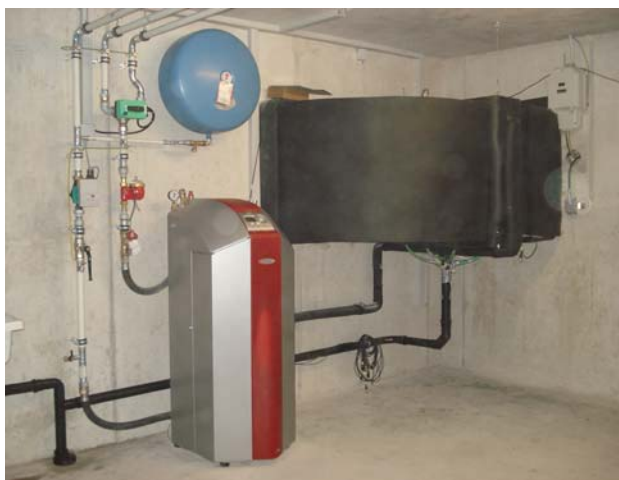
Abb. 2-6: Leistungsgeregelte L/W-WP mit Luftkanal (links) und Prinzipschema des Heizsystems mit leistungsgeregelter L/W-WP und Frischwassersystem zur Brauchwarmwasseraufbereitung (rechts).
