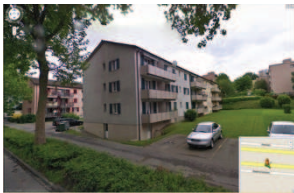
Abb.: Agglomerationswohnbau an der Badenerstrasse in Schlieren. Der landesweit typische Bau aus den 60er-Jahren ist viergeschossig, besitzt noch ein Schrägdach und ist entweder ungedämmt (Einschalenmauerwerk mit Aussenputz) oder wurde in den 80er-Jahren nach der Energiekrise saniert (40-80mm Dämmung mit Aussenputz oder hinterlüfteter Fassadenbekleidung).
