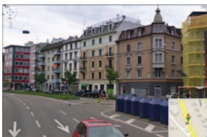
Abb.: Stadthäuser an der Seebahnstrasse in Zürich. Viele der Fassaden sind ungedämmt oder bei einer ersten Sanierung nur minimal mit Dämmung versehen worden. Teilweise sind die Erscheinungsbilder der Fassaden erhaltenswert. Das zweite vollständig erkennbare Gebäude von rechts wurde bis im April 2006 um zwei Geschosse aufgestockt und erhielt hofseitig eine komplett neue, vorgebaute Fassade mit Balkonen.
