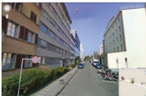
Abb.: Stadthäuser an der Secheron in Genf. Bauten im originalen Erstellungszustand wechseln sich mit sanierten Bauten ab. Neue Fassadenbilder und eine Aufstockung um ein bis drei Geschosse scheinen sinnvoll.
