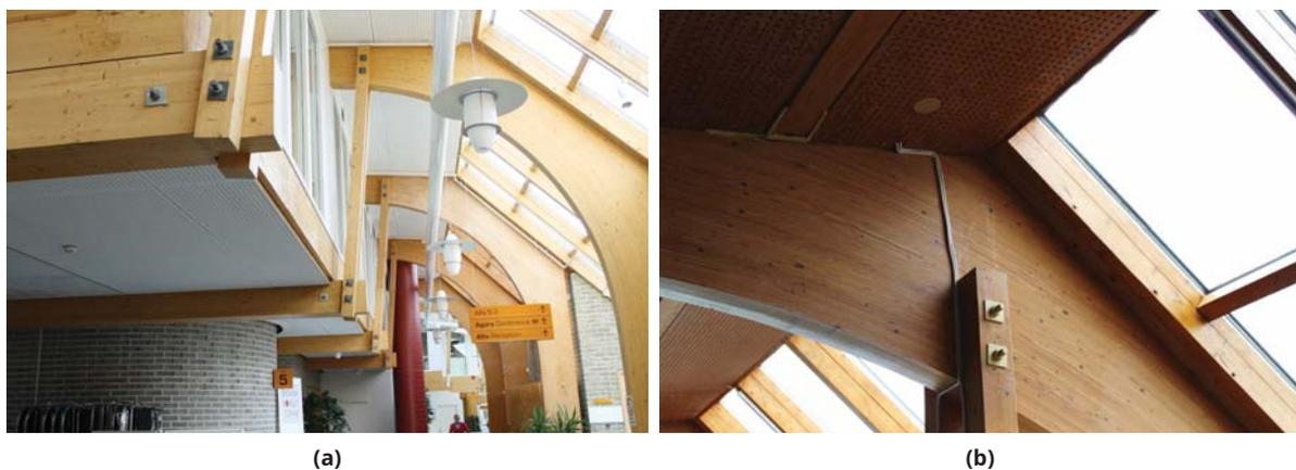
**Fig. 1.3:** Beispiele von Queranschlüssen mit Bauschrauben.
