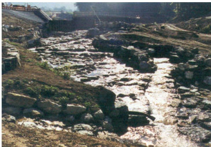
Figure 2 : passe à poisson fonctionnant à l'étiage
