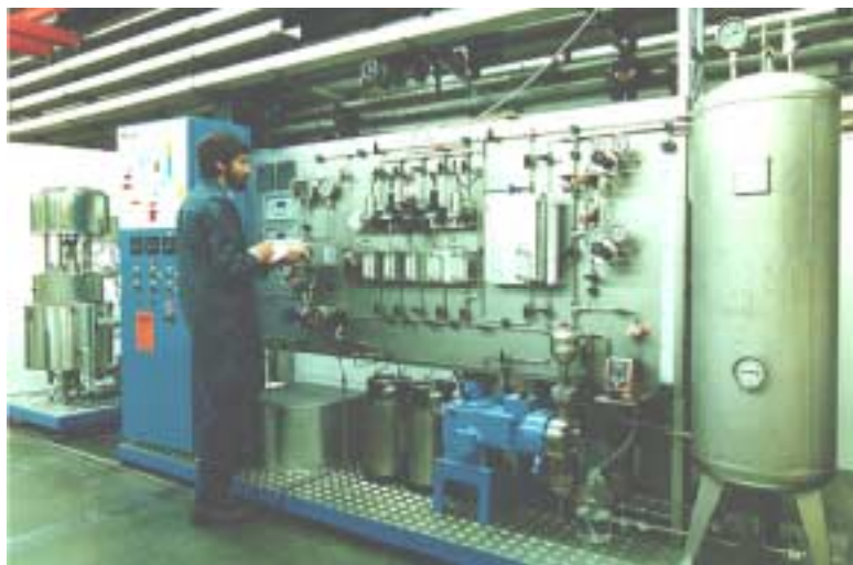
Figur 8: Heisswasserkreislauf des PSI für Risskorrosionsuntersuchungen unter simulierten SWR-Bedingungen (links: Autoklav mit Belastungseinrichtung, rechts: Niedertemperatur/-druckkreislauf zur Aufbereitung und Kontrolle der wasserchemischen Parameter).
