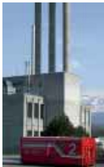
Une installation de gazéification du bois et une chaudière à mazout ont remplacé, pour le chauffage, trois grandes chaudières à mazout.
