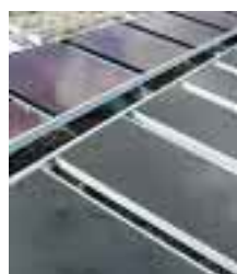
Les installations photovoltaïques fournissent du courant continu qui est injecté dans le réseau après transformation en courant alternatif par un onduleur.
