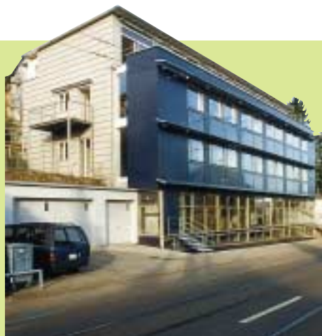
La façade principale après les travaux, avec ses capteurs solaires intégrés et ses modules photovoltaïques qui donnent de l'ombre en été.
