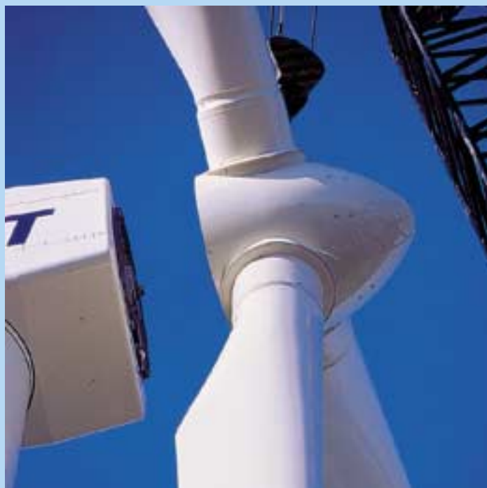
Les deux nouvelles éoliennes du Mont-Crosin ont été montées en automne 2001.
