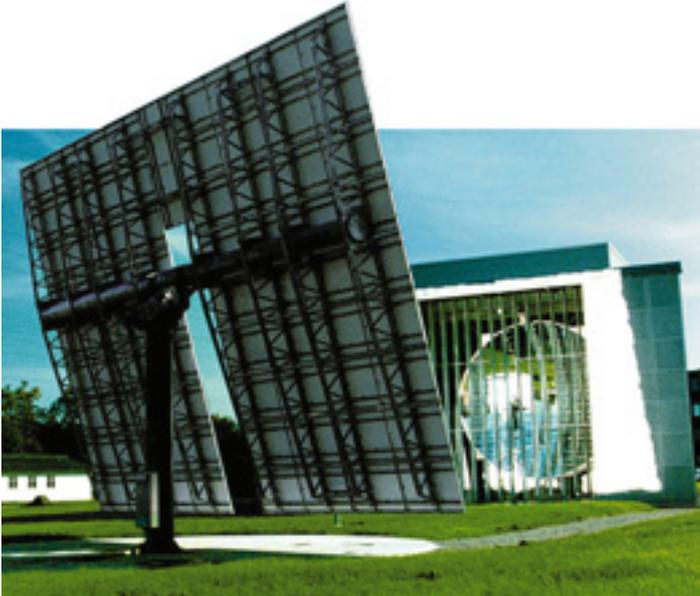
Der für solarchemische Projekte genutzte 40-kW-Sonnenofen am PSI besteht aus einem drehbaren Flach- und einem festen Parabolspiegel. (Foto: PSI)
