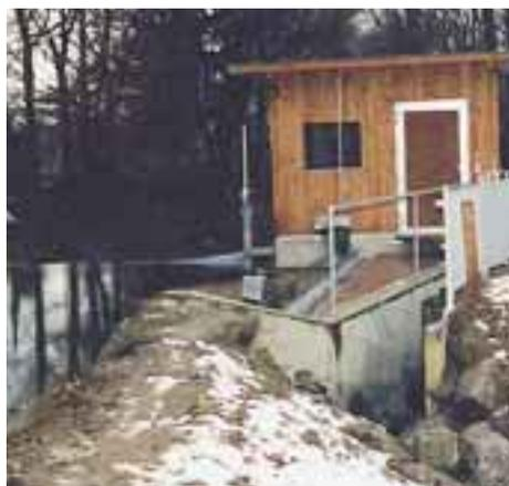
*Turbinenhaus mit vorgelagertem Rechenreiniger, der durch den Differenzdruck am Rechen bedarfsgerecht gesteuert wird.*
