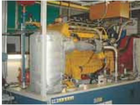
Seit Juli 2002 ist ein SwissMotor in einem Wärmeverbundsystem in Münchenstein (BL) im Einsatz: (v.l.n.r.) 3-Wege-Katalysator, Ladeluftkühler, 6-Zylinder-Gasmotor mit 19 kW<sub>el</sub> geregelte Abgasrückführung.
