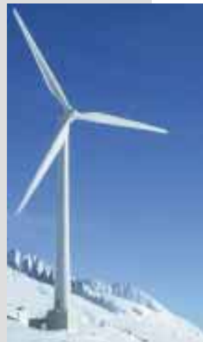
Die neue Anlage auf dem winterlich verschneiten Gütsch. (Foto: Suisse Eole)
