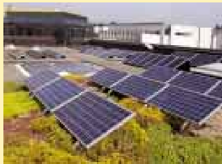
Demosite auf dem Gelände der EPFL: Demonstration unterschiedlicher Integrationslösungen für Photovoltaik-Module, beispielsweise auf einem begrüntem Flachdach.
