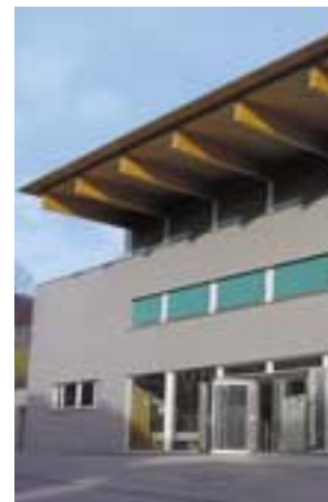
Mit einer Wärmepumpe wird die Energie des Tunnelwassers aus dem Ricken für die Beheizung der Mehrzweckhalle von Kaltbrunn verwendet. (Fotos: R. Cotting)
