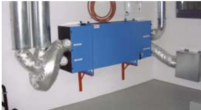
Der Wärmetauscher stellt ein zentrales Systemelement der Komfortlüftung dar und bestimmt wesentlich die erzielbare Energieeffizienz der Anlage. Er ermöglicht die Rückgewinnung von drei Vierteln der Wärme.
