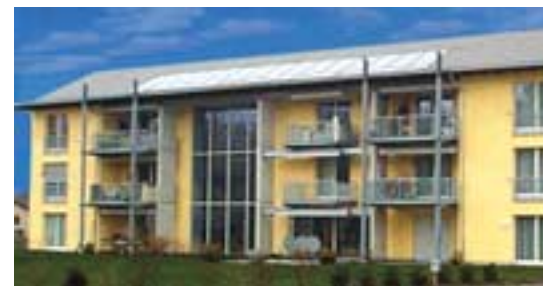
Vorwärmanlage als interessantes Spezialsystem für ein Mehrfamilienhaus.
