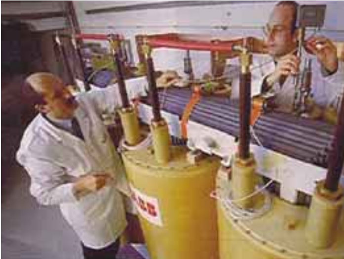
Der 1997 entwickelte supra-leitende Transformator für 630 kVA nutzt HTS-Bänder als Wicklung.
