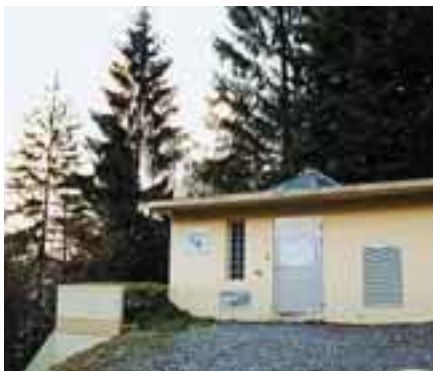
Auf dem bestehenden Trinkwasser-Teilungsreservoir von La Rasse wurde 1998 das Turbinenhaus erbaut.
