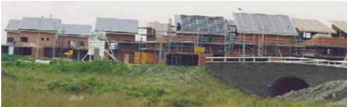
AluTec-Installation in Holland mit nur einer Folienabdeckung als dichtende Dachhaut.
