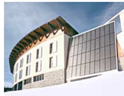
Das Kombi-System des Hotels Silvretta-Haus nutzt auf rund 2000 m.ü.M. eine Kollektorfläche von 60 m².
