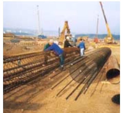
Armierungskorb mit den Polyethylen-Rohren, die für den Energieaustausch zwischen Gebäude und Untergrund dienen.
