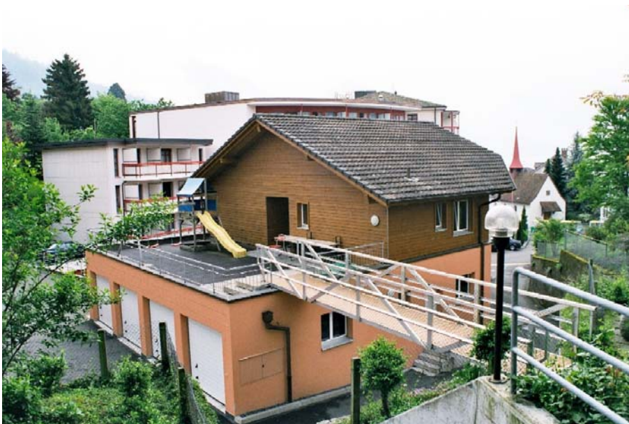
Figur 9: Das Gebäude Seestrasse 54a (Fabrikationsgebäude mit aufgesetztem Châlet) ist parallel zur Seestrasse 54 ebenfalls an die Fernleitung angeschlossen.
