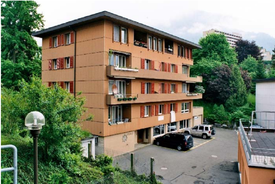
Figur 8: Das Gebäude Seestrasse 54 wird über eine Fernleitung direkt aus der Wärmezentrale in der Kreuzstrasse 16 beheizt.
