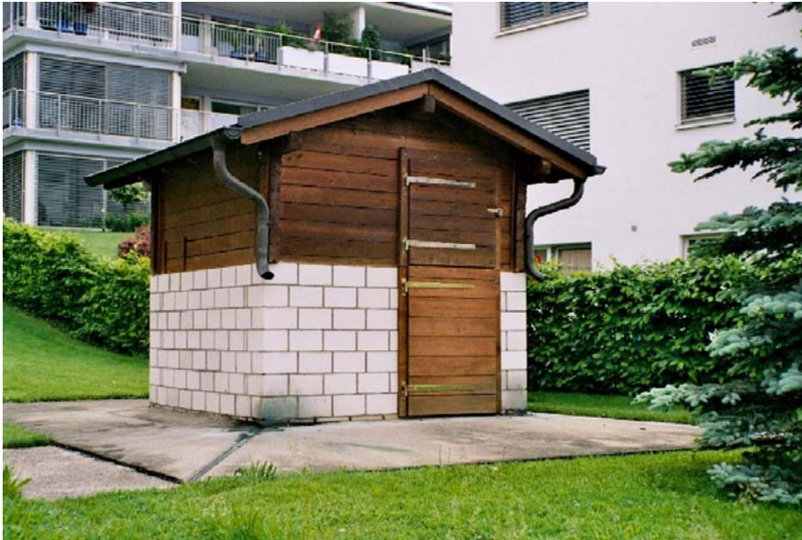
Figur 3: Ein gegenüber früher leicht erhöhtes Châlet beherbergt den Bohrlochkopf.
