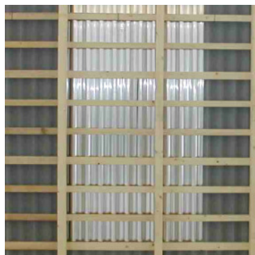
Fig. 2: Beidseitig blankes Aluminium- blech ersetzt die Dachhaut aus Eternit
