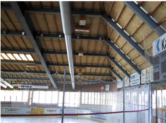
Fig. 1: Zustand vor Sanierung mit Faserholzdecke
