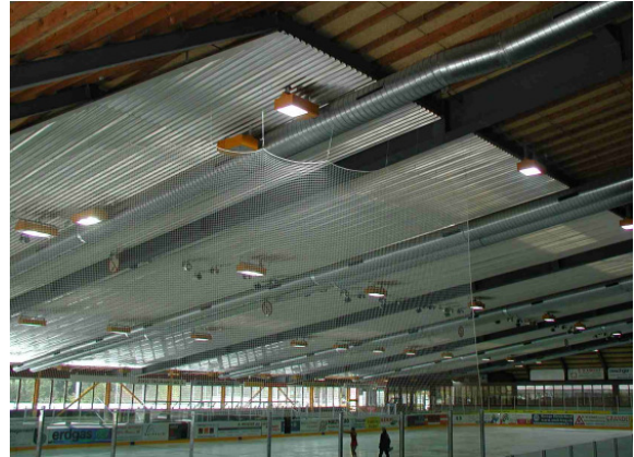
Fig. 2: Neuinstallierte Aluminium-Deckenuntersicht
