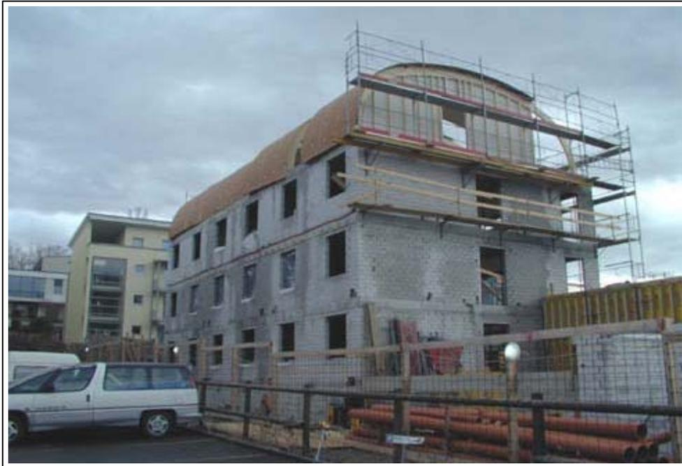
**Schritt 1:** Einmessen des Gebäudes durch Lasergerät aufgrund der statischen Vorgaben. (Haus C / Nord- und Westfassade)
