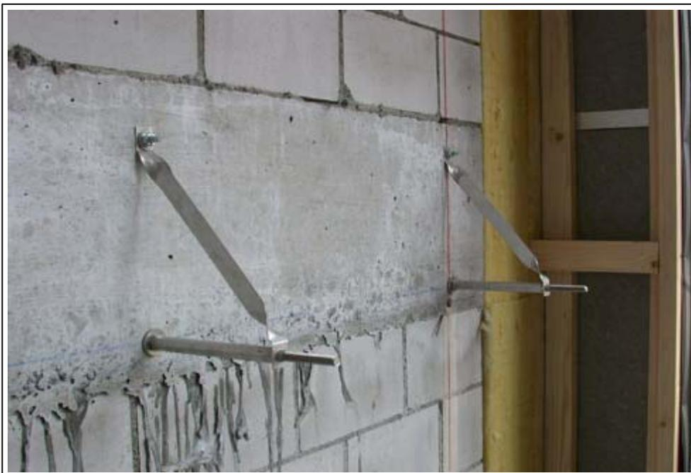
**Schritt 2:** Bohren und Setzen der Unterkonstruktionsanker **Typ A** zur Aufnahme der vertikalen Lasten (Eigengewicht) in der Betondecke.
