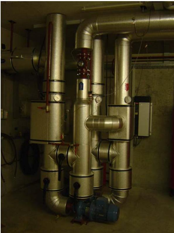
*Abbildung/Tabelle 22 - Fernwärmepumpengruppe und -regulierung*
