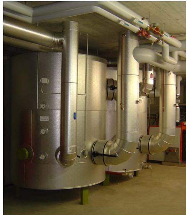
*Abbildung/Tabelle 21 - technische Wärmespeicher*
