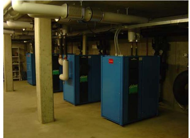
*Abbildung/Tabelle 20 - Ansicht Wärmepumpen*
