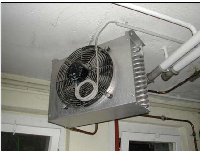
Abbildung 17: Unterkühler zur Beheizung des Trockenraums
