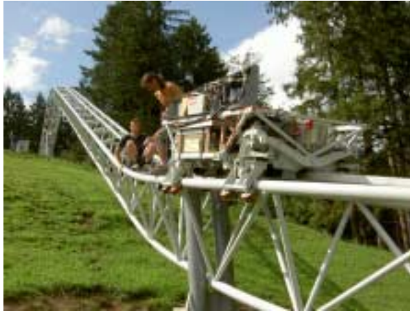
Bild: Feinjustage des Triebstockes
