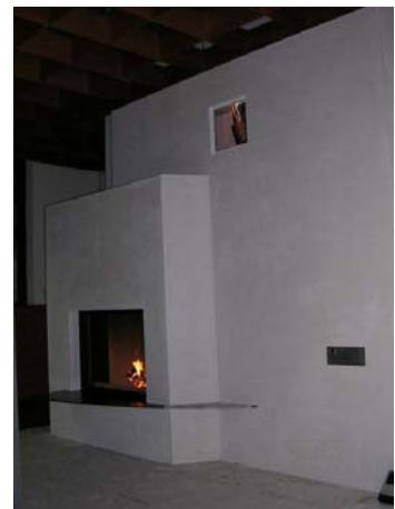
Abbildung 12 Erste Inbetriebnahme, Wartungsöffnung offen. (Quelle: Eigene Fotos)
