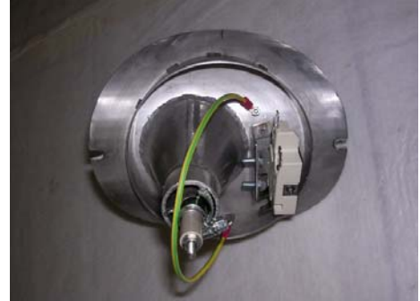
Abbildung 7 Neuer Filtereinsatz, vor Inbetriebnahme von hinten (Quelle: Eigene Fotos)
