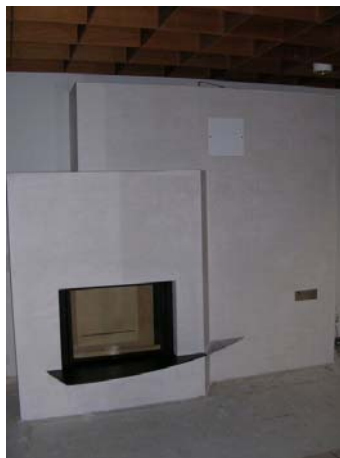
Abbildung 11 Fertige Anlage im Rohbau. (Quelle: Eigene Fotos)
