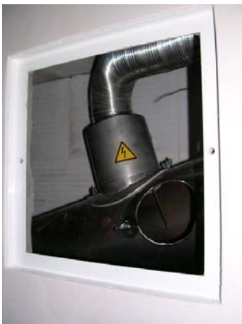
Abbildung 10 Blick durch Wartungsöffnung. Inspektionsdeckel des Kaminsrohres offen. (Quelle: Eigene Fotos)
