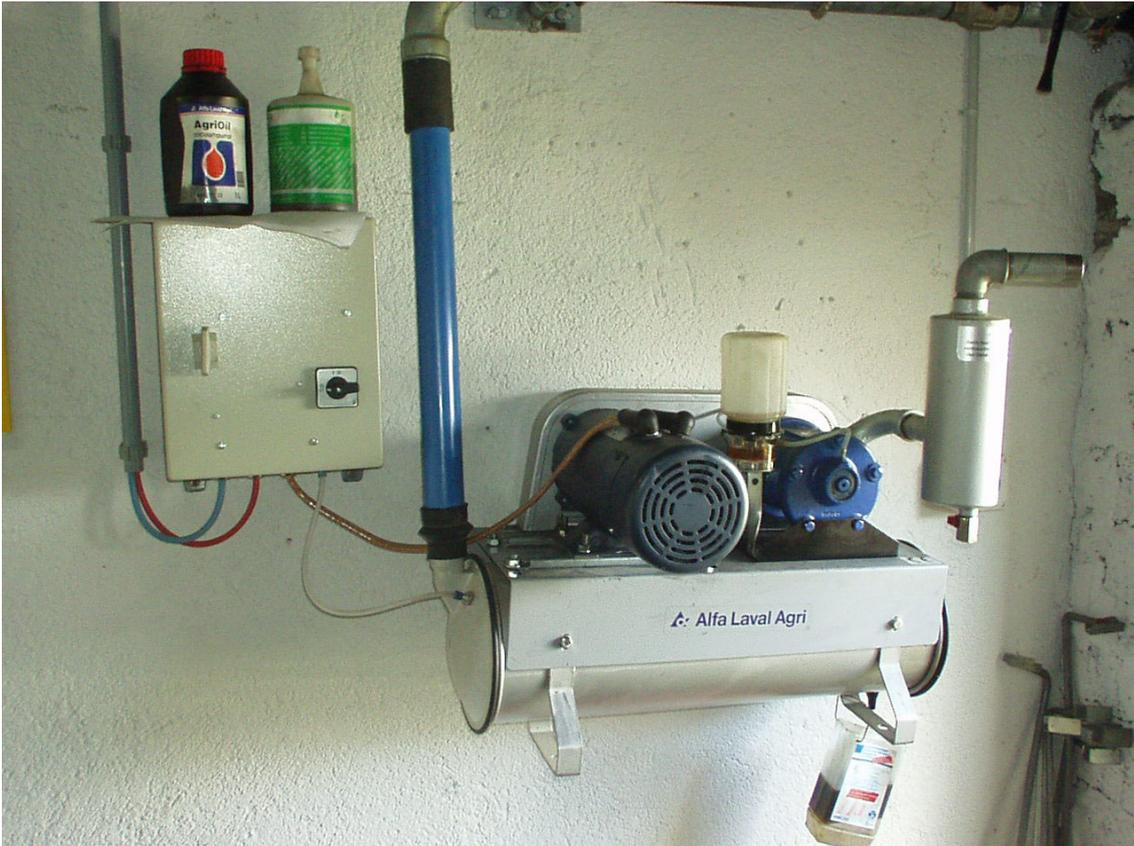
Abb. 2: Melkmaschine 24V DC auf der Mastrilser Alp. Damit werden 100 Kühe täglich zweimal gemolken
