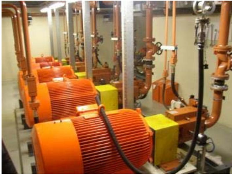
**Abbildung 17:** *Hydraulikpumpen*
