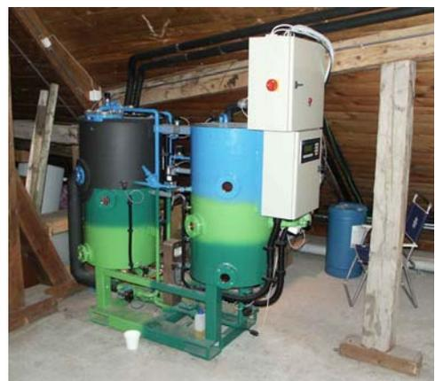
**Bild 1:** 15 kW Absorptionsmaschine Weingut Schloss Salenegg (EAW WEGARCAL 15)
