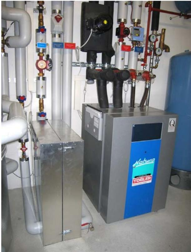
Abbildung 2: Wärmepumpe (rechts) und aussenliegender Plattenwärmetauscher (links)
