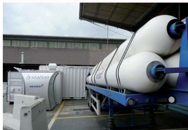
Figur 13: (oben) Wasserstoff-Kommunalfahrzeug «Bucher CityCat H2». (unten) Mobile Wasserstofftankstelle auf dem Werkhofareal in Basel [33]
