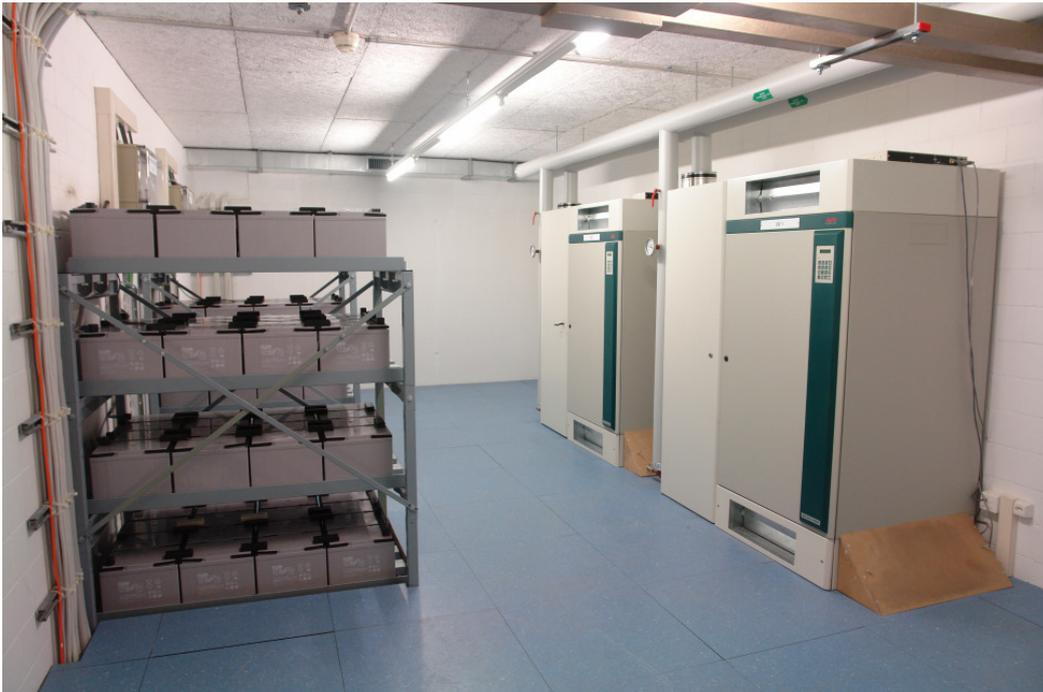
**Figur 1:** Die zwei redundanten 80kVA-USV-Anlagen mit WRG-Zusatz (rechts) und die zugehörigen Batterien (links) des Gebäudes *Gretag/SAP*
