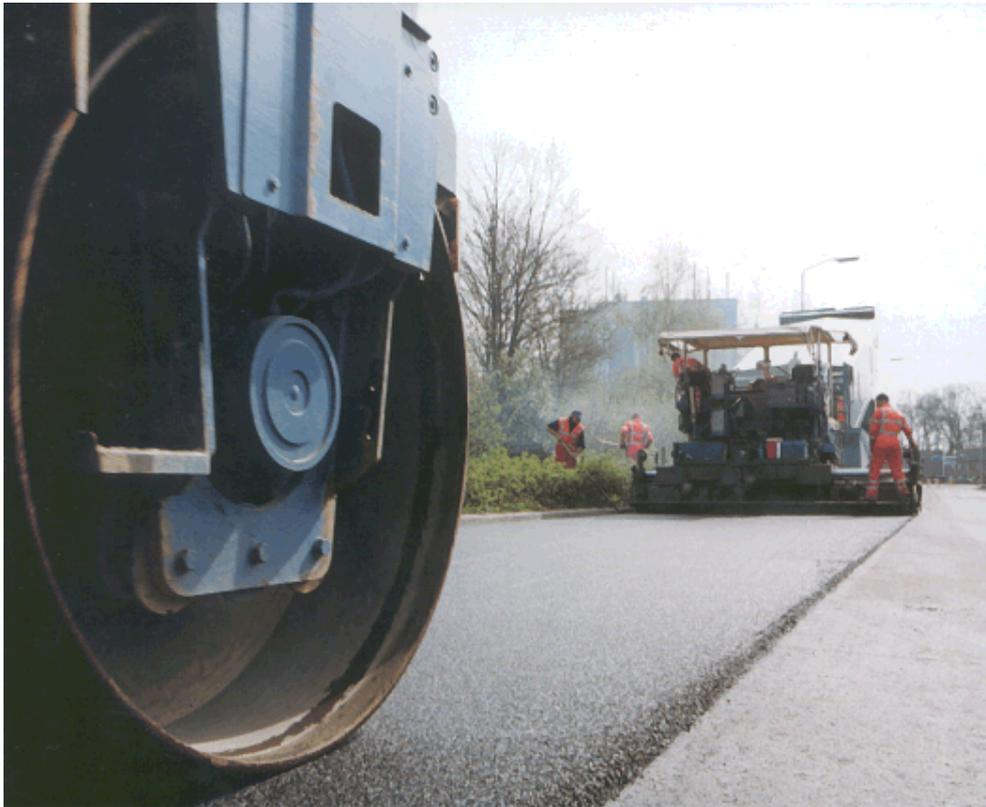
Abbildung 12 *Das Anlegen einer Strassendecke*
