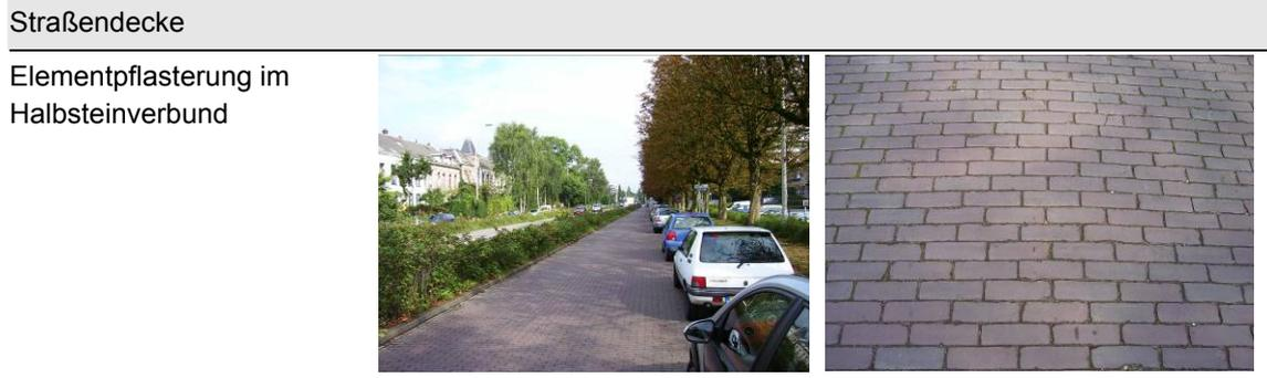
Abbildung 10 Beispiel für eine Elementpflasterung im Fischgrätverbund und im Halbsteinverbund
