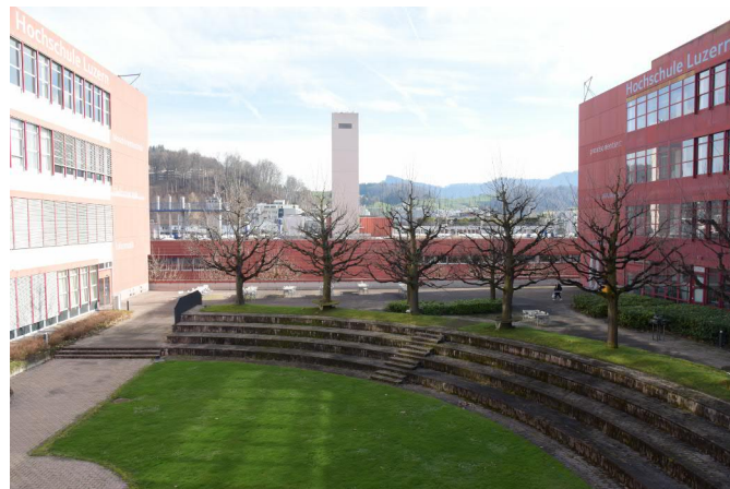
Abbildung 6: Innenhof HSLU, Sicht Richtung Nordosten
