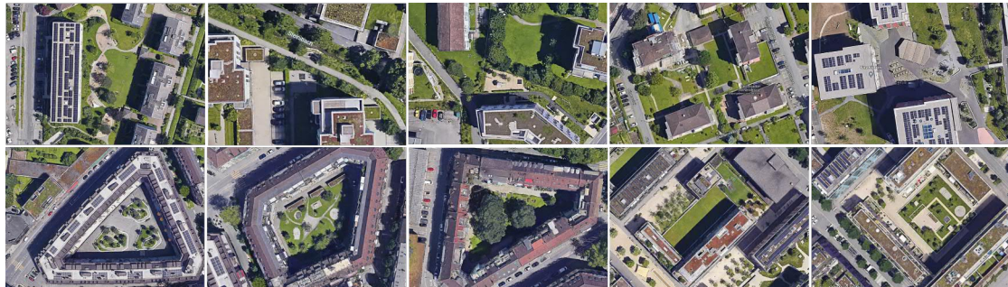
Abbildung 99: Übersicht der Innenhöfe ( https://earth.google.com/web ) der ersten Feldmesskampagne
