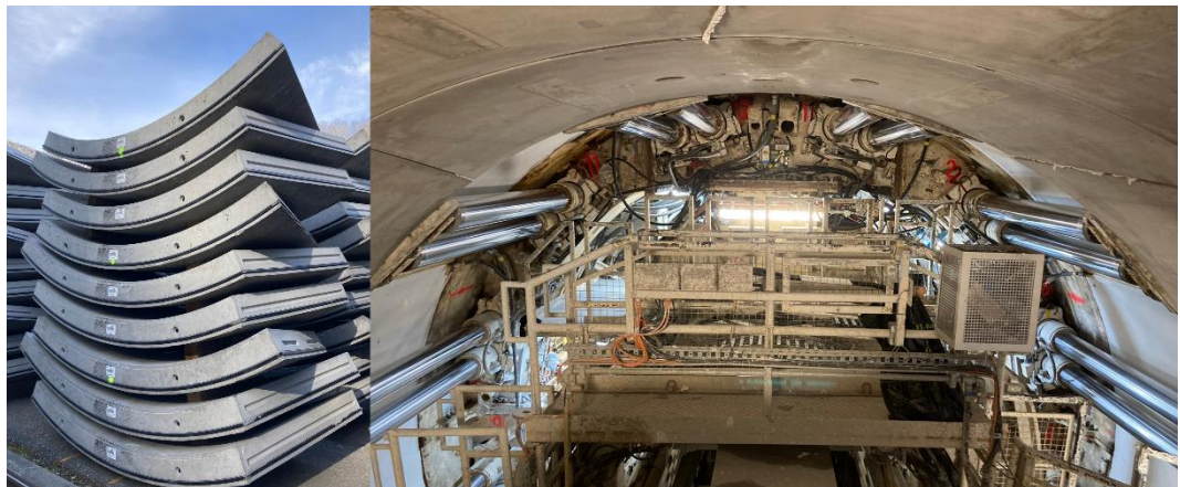
Abbildung 1: Gestapelte Tübbinge (links) und Tübbingausbau mit ausgefahrenen Vortriebspresen einer TBM, die sich in der Ringfuge paarweise auf den zuletzt eingebauten Tübbingring abstützen (rechts).
