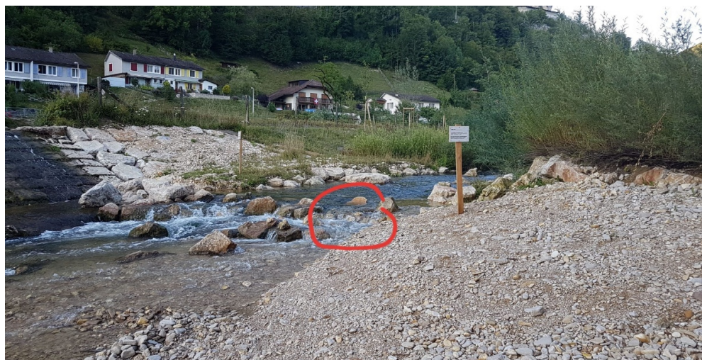
Figure 22 Seuil indésirable construit à l'entrée de la rivière de contournement. Source : Valentin Iseli, 2020.
