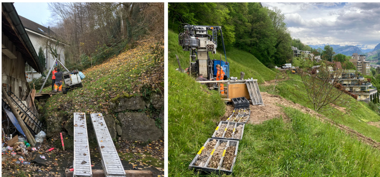
Figur 4: Rammsondierung (links) und Kernbohrung (rechts) in steilem Baugelände
