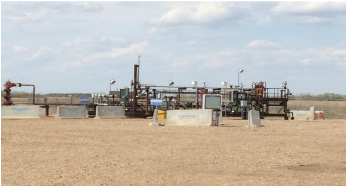
Abbildung 1: Obertägige Komponenten einer geologischen CO 2 -Speicherinfrastruktur am Beispiel des Quest Carbon Capture and Storage (CCS) Projekts in Kanada. Seit 2015 werden im Rahmen des Quest CCS-Projekts in Alberta, Kanada, jährlich rund 1 Million Tonnen CO 2 (ca. 30 kg/s) in 2'000 bis 2'500 Metern Tiefe dauerhaft geologisch gespeichert. Von drei verfügbaren Injektionsbohrungen ist derzeit nur eine aktiv in Betrieb. Der unterirdische Speicher erstreckt sich über 3'700 km 2 und ist für ein Gesamtvolumen von 25 Millionen Tonnen CO 2 konzessioniert. Bislang wurden etwa 10 Millionen Tonnen injiziert – diese erzeugen im Speichergestein eine CO 2 -Fahne mit rund 50 km 2 Ausdehnung und etwa 40 Metern Mächtigkeit.
