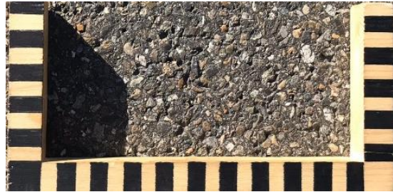
Altstätten, Trogenerstrasse SDA 8-12, 2016 Messjahr 2019
