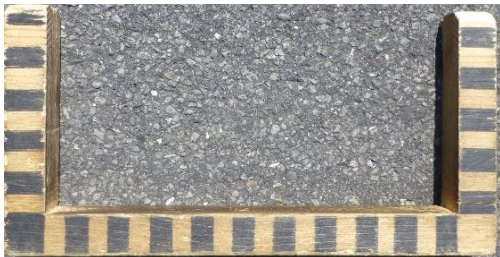
St. Margrethen, Brücke Gaissau – Ruederbach DSAK 4, 2017 Messjahr 2023
