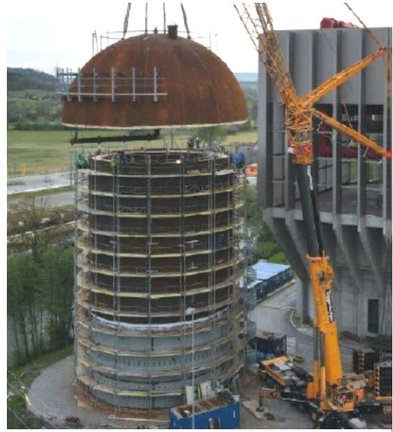
Abbildung 11: Bedruckter Stahltank von Renergia in Perlen.
