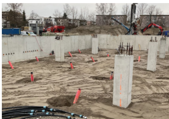
Erdsonden - Wärmespeicher bei der EMPA (CH) im Bau. Bild: Implenia.
