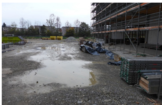
EMPA Erdsonden - Wärmespeicher nach Fertigstellung
