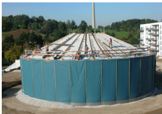
6'000 m 3 Speicher der Stadtwerke München GmbH in München-Ackermannbogen im Bau
