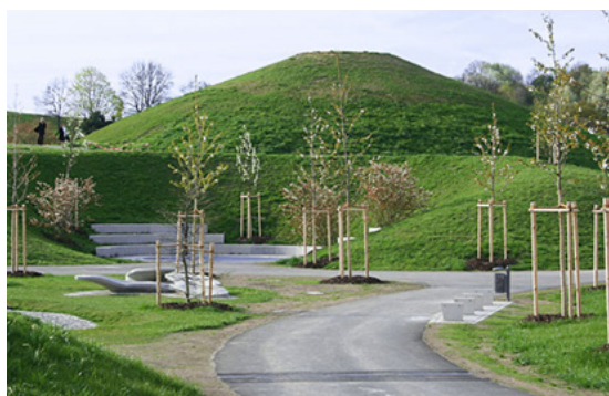
6'000 m 3 Speicher München-Ackermannbogen nach Fertigstellung
