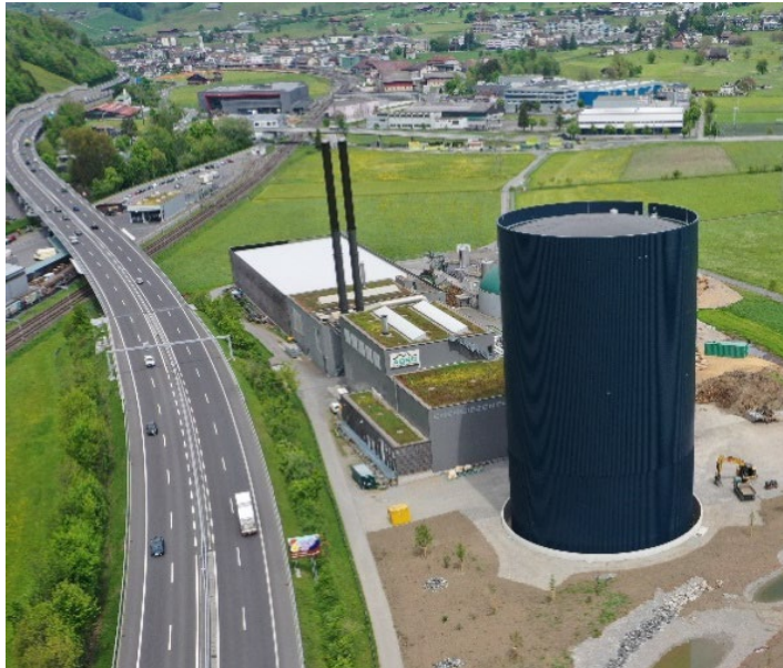
Abbildung 10: Druckloser Wärmespeicher von Agro Energie Schwyz.
