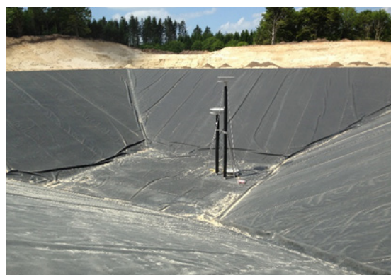
Bau des Erdbecken - Wärmespeichers in Dronninglund (DK, 60'000 m³)
