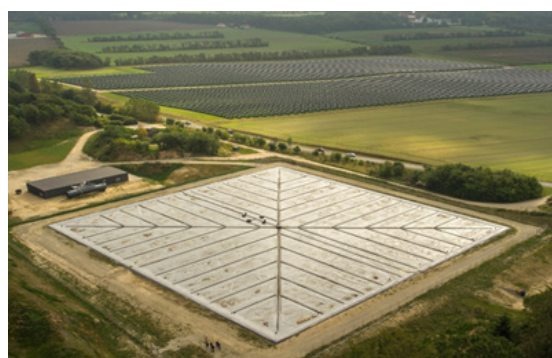
Der Erdbecken - Wärmespeicher in Dronninglund im Endzustand (Stand 2020)
