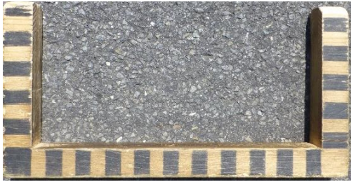
St. Margrethen, Brücke Gaissau – Ruederbach DSAK 4, 2017 Messjahr 2023
