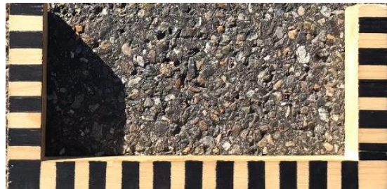
Altstätten, Trogenerstrasse SDA 8-12, 2016 Messjahr 2019
