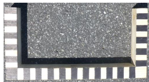
St. Margrethen, Brücke Gaissau - Ruederbach, DSAK4, 2017 Messjahr 2019
