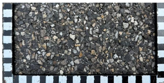
Trimbach, Winznauerstrasse SDA 8-12, 2019 Messjahr 2025
