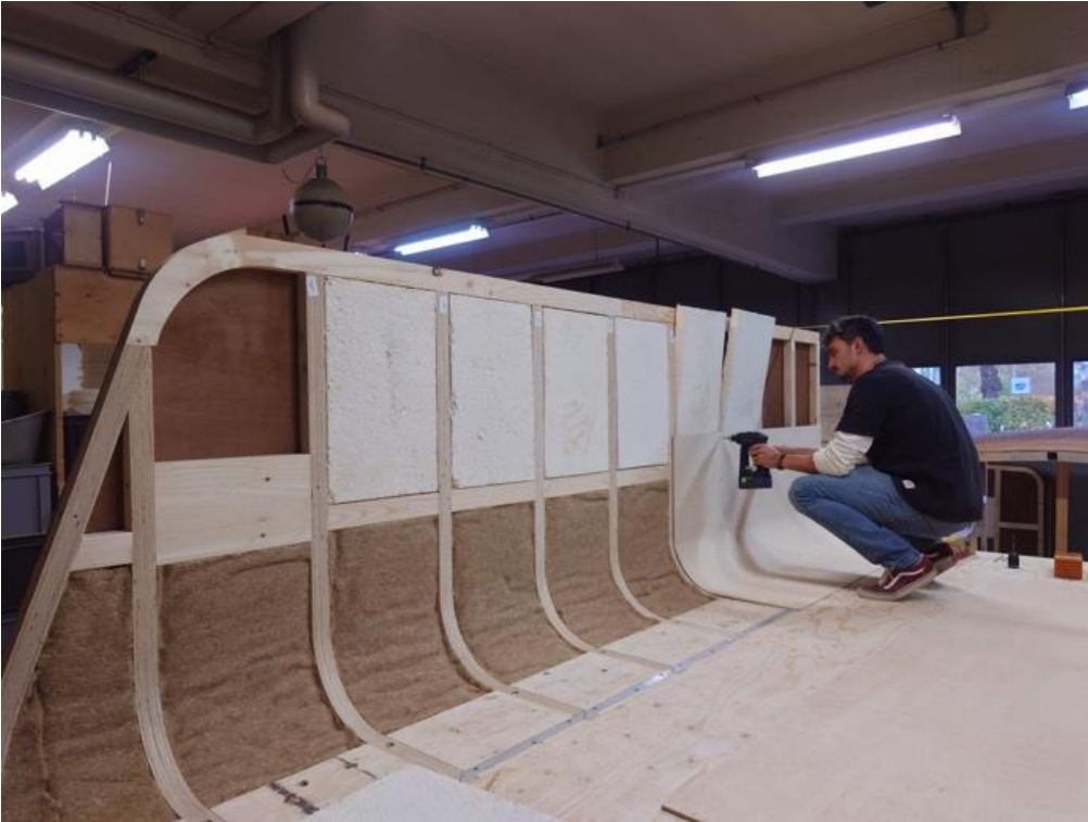
Abbildung 9: Montage der tragenden Innenstruktur mit 4 m langen Timcelium-Paneelen – präzise Ausrichtung für Systemanschlüsse.
