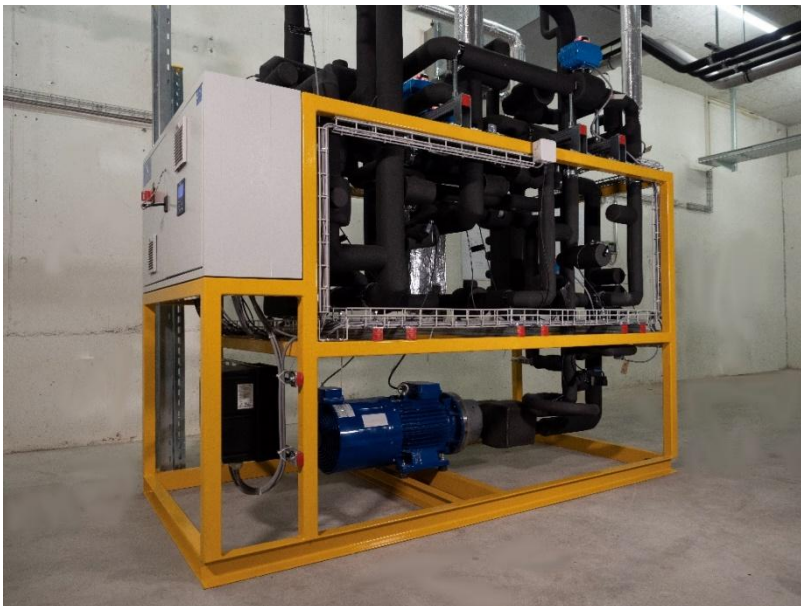
Abbildung 22: Energie-Transfer-System (ETS), inklusiv zugehörige Steuerung, aufgebaut auf einem separaten Rahmen.
