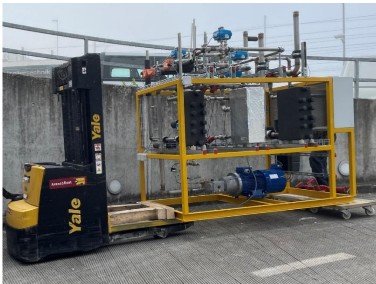
Abbildung 2: Einbringung des ETS in den Maschinenraum, an den endgültigen Standort.
