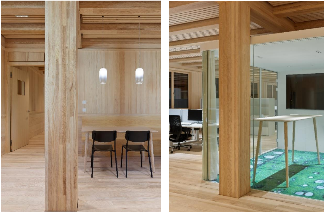
Abbildung 34: Stützen aus Eschenholz Quelle: PIRMIN JUNG Schweiz AG
