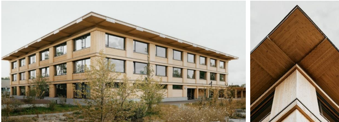
Abbildung 16: Beispiel Vordach zum Schutz der Fassade Quelle: Ladina Bischof
