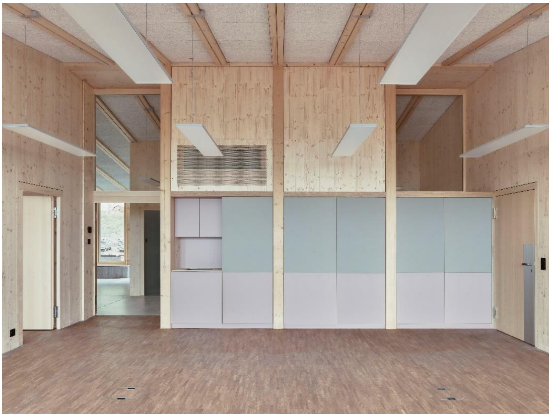
Abbildung 12: Bekleidete Installationsräume Quelle: Lukas Murer
