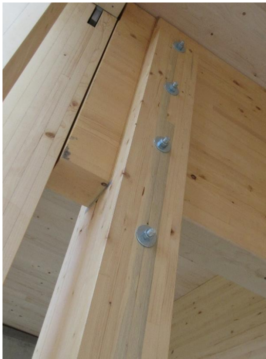
Abbildung 29: Bolzenverbindung Quelle: PIRMIN JUNG Schweiz AG
