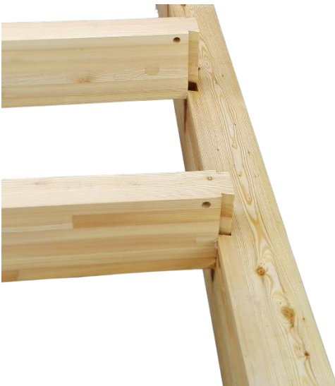
Abbildung 27 Schwalbenschwanzverbindung Quelle: PIRMIN JUNG Schweiz AG
