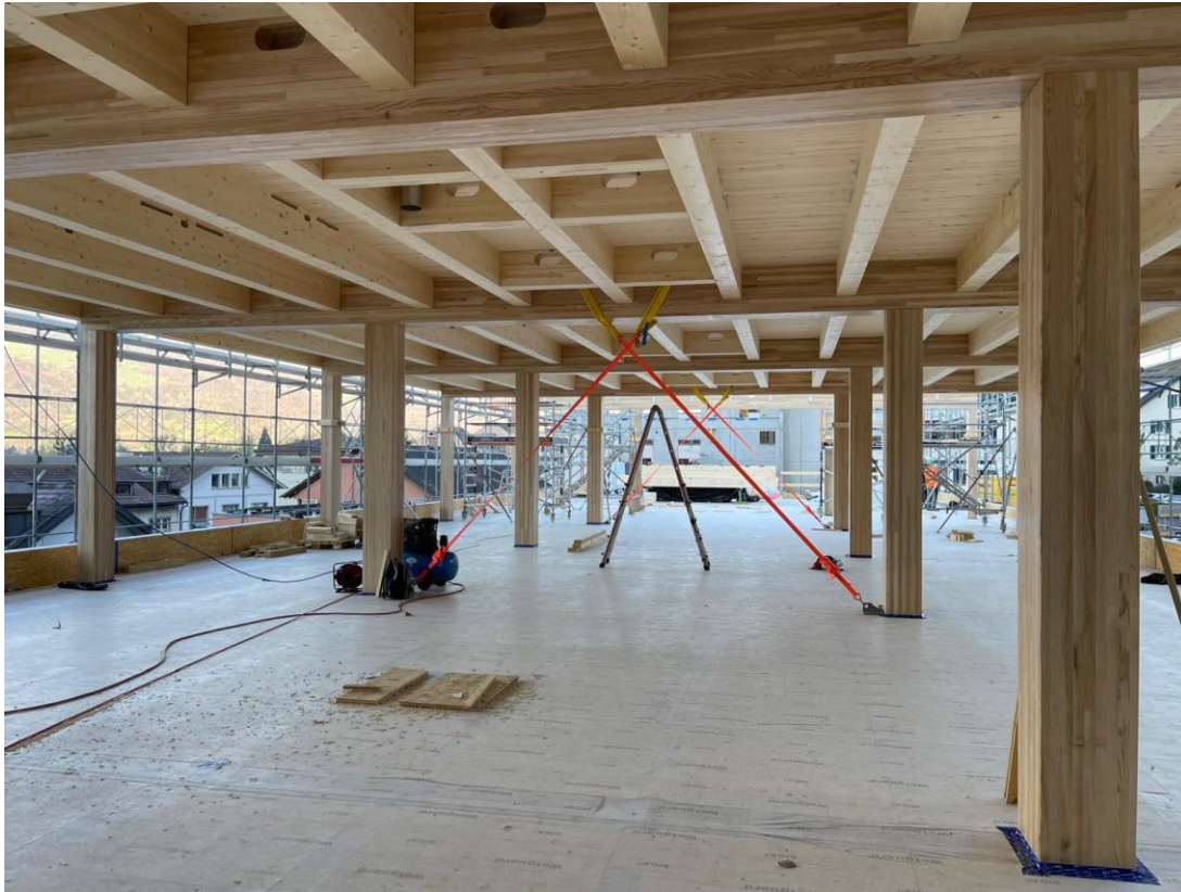
Abbildung 10: Stützen-Unterzug-System Quelle: PIRMIN JUNG Schweiz AG
