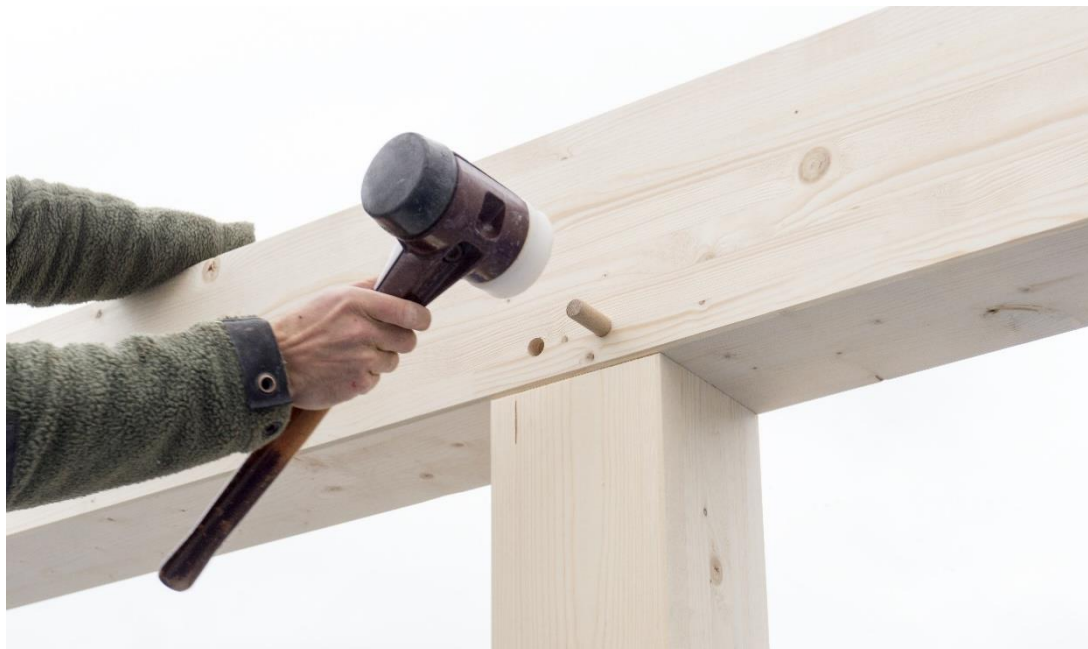
Abbildung 22: Zapfenverbindung mit Holzdübeln Quelle: DGJ Architektur GmbH
