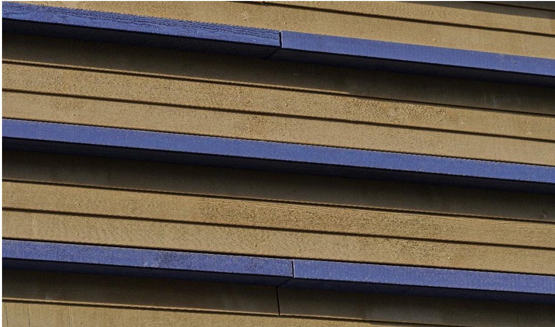
Abbildung 39: Fassade mit Fugen zur Austrocknung Quelle: PIRMIN JUNG Schweiz AG
