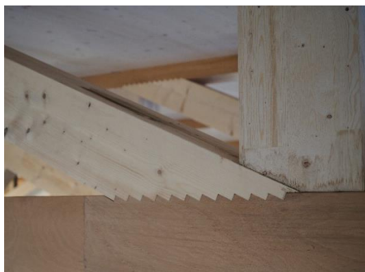
Abbildung 24: Treppenversatz Quelle: Horst Pütz
