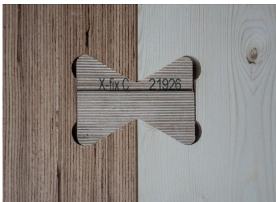
Abbildung 23: Doppelschwalbenschwanz-Verbinder Quelle: Uli Hillenbrand
