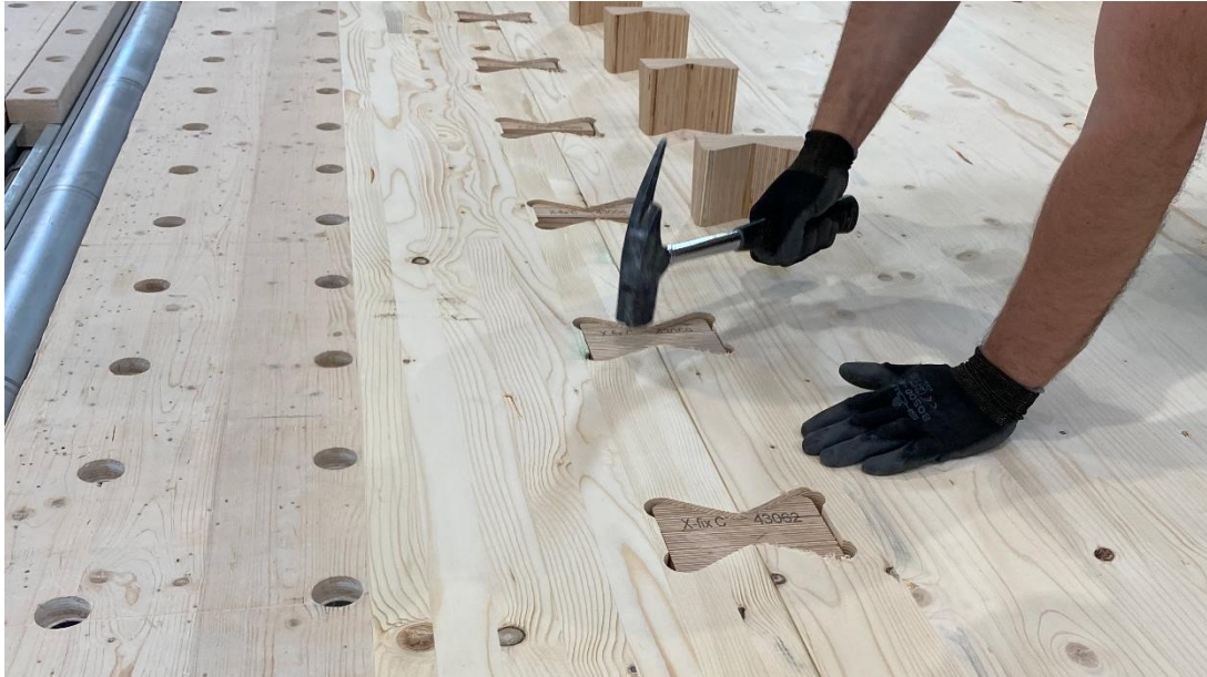
Abbildung 36: X-Fix Verbindungen Quelle: PIRMIN JUNG Schweiz AG
