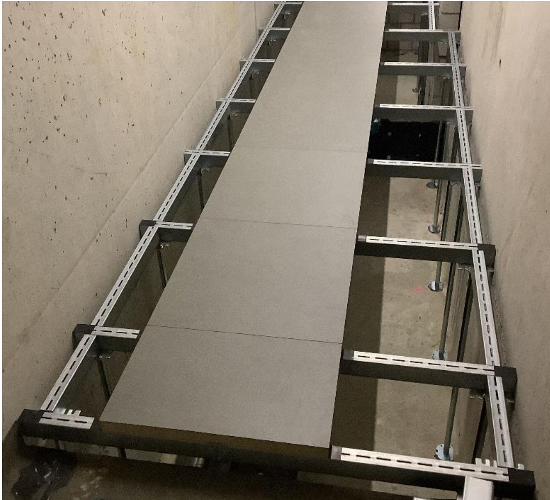
Abbildung 14: Doppelboden Quelle: PIRMIN JUNG Schweiz AG
