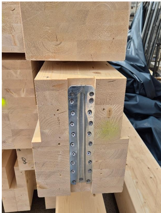
Abbildung 30: Einhängeverbinder Quelle: PIRMIN JUNG Schweiz AG
