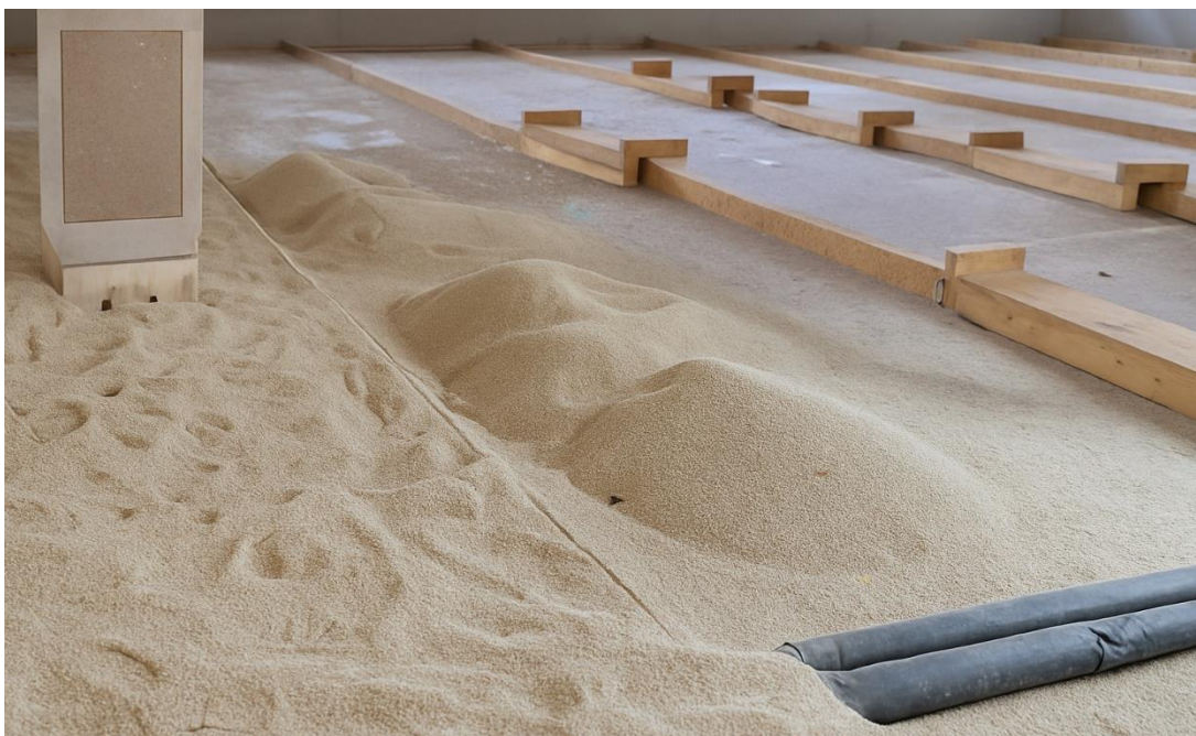
Abbildung 15: Lose Splittschüttung als Installationsebene Quelle: PIRMIN JUNG Schweiz AG
