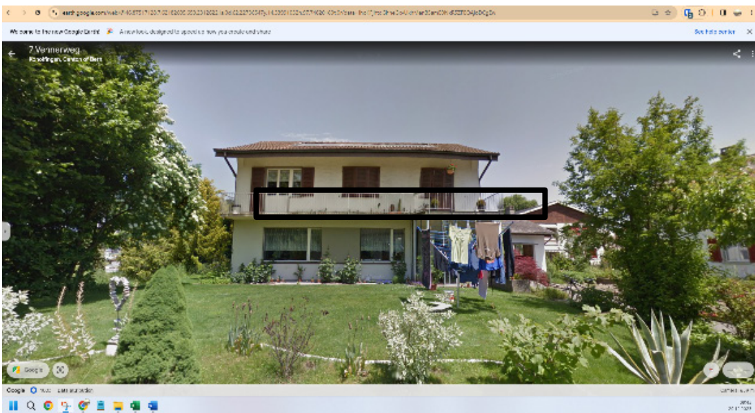
Abbildung 14: Beispiel einer Gebäudefassade mit 1 Balkon, einer summierten Balkonlänge von 7 m und maximal 2 bzw. 3 Modulen. Quelle: Google Maps. Für Option 1 wurde ein Produktionspotenzial von 593kWh/Jahr berechnet, für Option 2 von 605 kWh/Jahr, für Option 3 von 794 kWh/Jahr, für Option 4 von 875kWh/Jahr und für Option 5 908 kWh/Jahr. Quelle: Google Street View.
