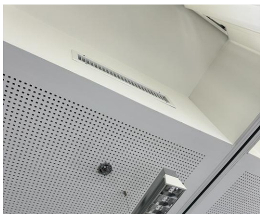
Abbildung 49: Luftabgabe: Quellluftauslass und Abluftgitter.
