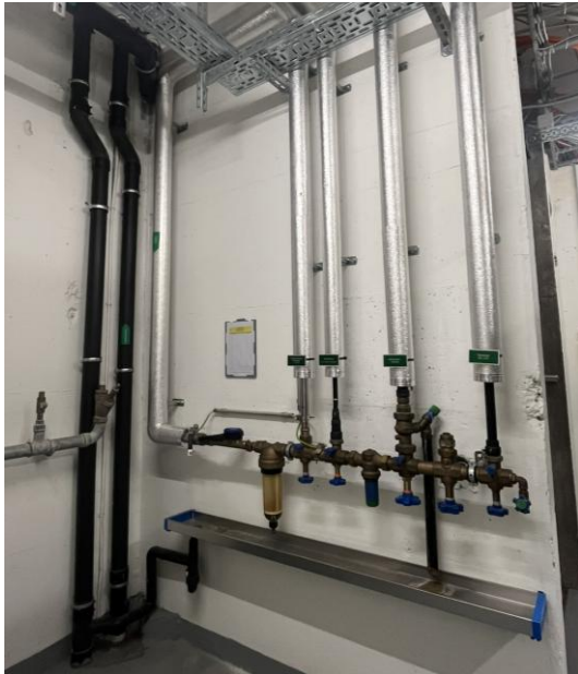
Abbildung 51: Sanitärverteiler mit Armaturen.
