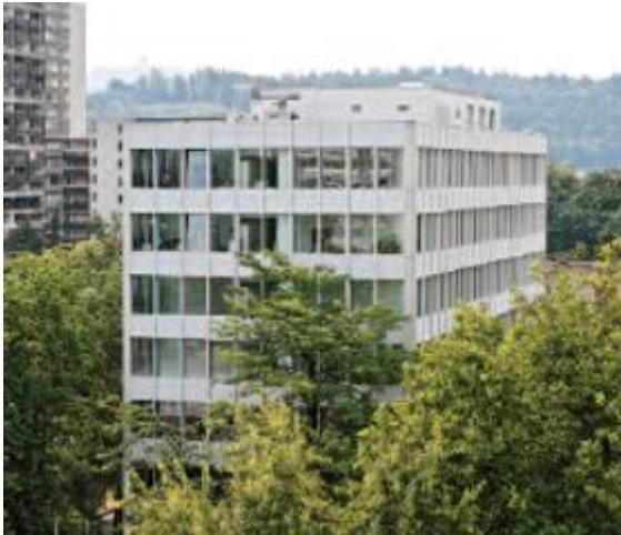
Abbildung 4: Verwaltungsgebäude in der Fellerstrasse in Bern.
