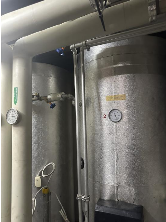
Abbildung 28: Brauchwarmwasserspeicher.
