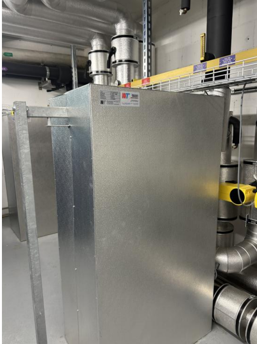
Abbildung 42: Übergabestation von Fernwärmeanschluss im 2. Untergeschoss.
