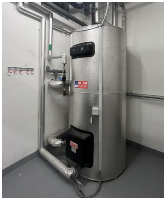
Abbildung 50: Brauchwarmwasserspeicher.
