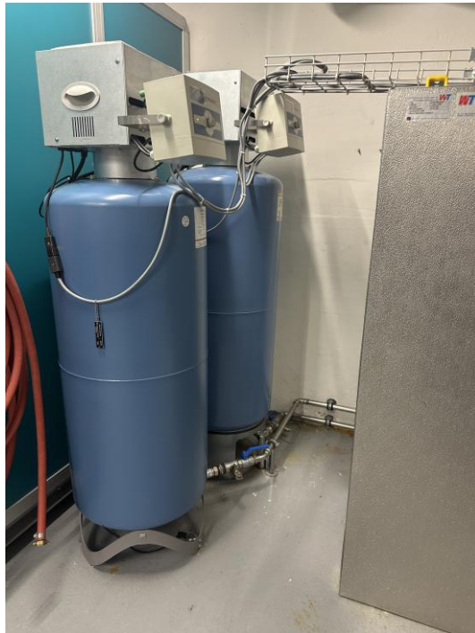
Abbildung 47: Expansionsanlage Heizung und Kälte.
