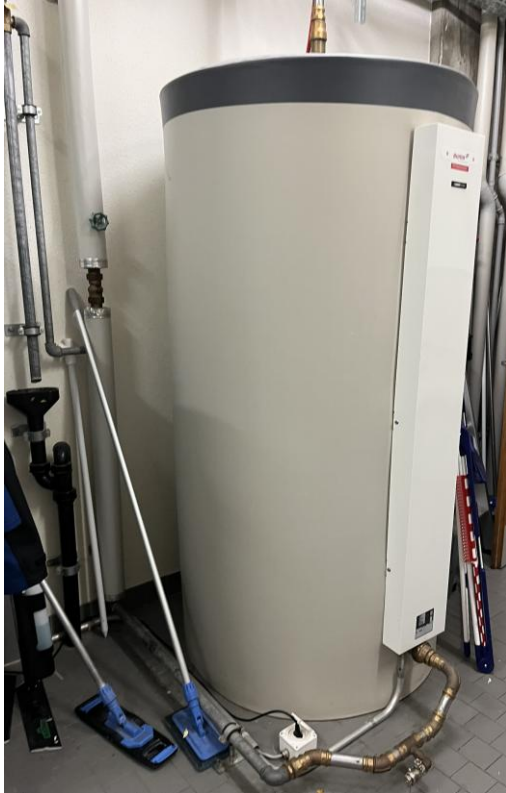
Abbildung 38: Elektrischer Brauchwarmwassererwärmer.
