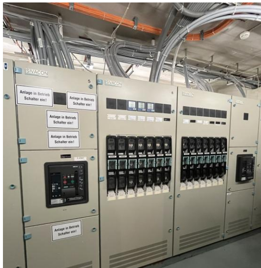
Abbildung 15: Neue Elektroverteilung im Untergeschoss.
