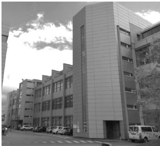
Abbildung 2: Verwaltungsgebäude Albis Haus C (links) und Haus D (rechts) in Zürich.
