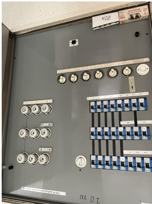
Abbildung 32: Elektro-Unterverteilung.
