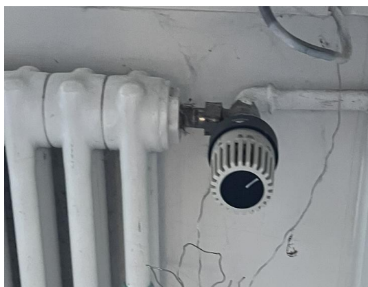
Abbildung 35: Heizkörper mit Thermostatventil.
