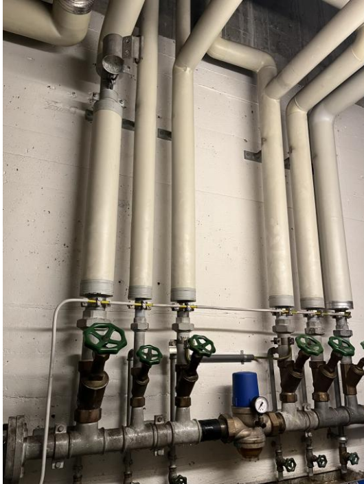
Abbildung 39: Sanitärverteiler mit Armaturen.
