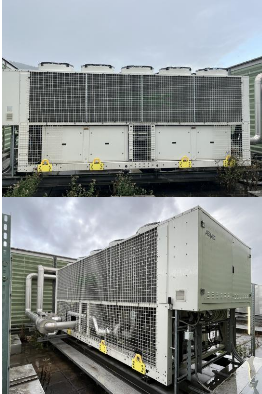
Abbildung 23: Kaltwassersatz / reversible Kälte-Wärmepumpenanlage auf dem Dach.
