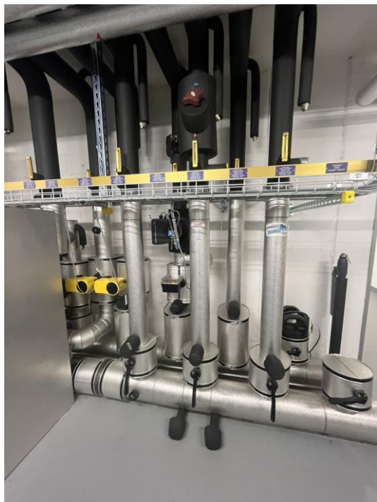
Abbildung 43: Wärmeverteiler inkl. Pumpen und Armaturen.
