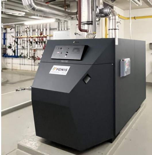
Abbildung 33: Wärmeerzeugung, Gasheizkessel.
