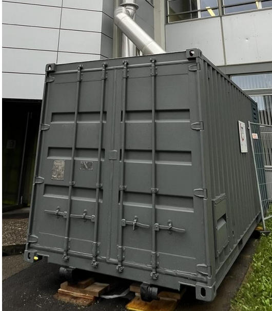
Abbildung 16: Provisorische Wärmeerzeugung über einen mobilen Gasheizkessel.
