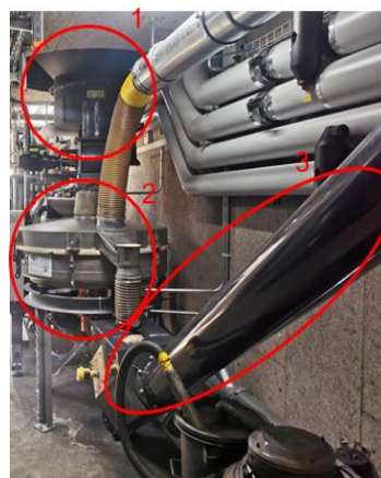
Abbildung 1: 1. Schneckenaustragung des Hauptsilos, 2. Feinanteilabscheider, 3. Förderschnecke
